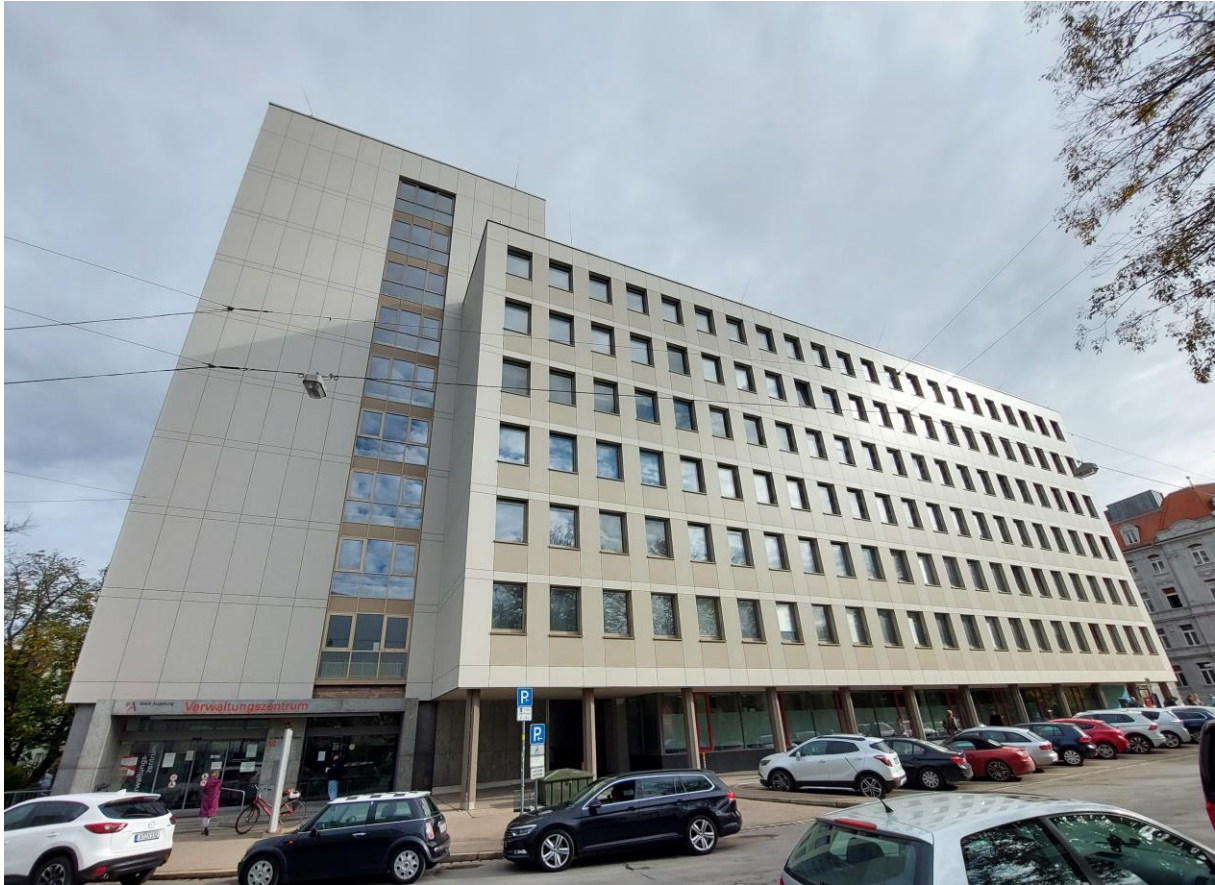
Fassadensanierung des Verwaltungszentrums, Bild: Nadine Maier, Hochbauamt Augsburg
