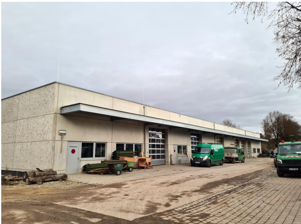
Neue Werkstatt auf dem Betriebsgelände des AGNF, Bild: Anette Vedder
