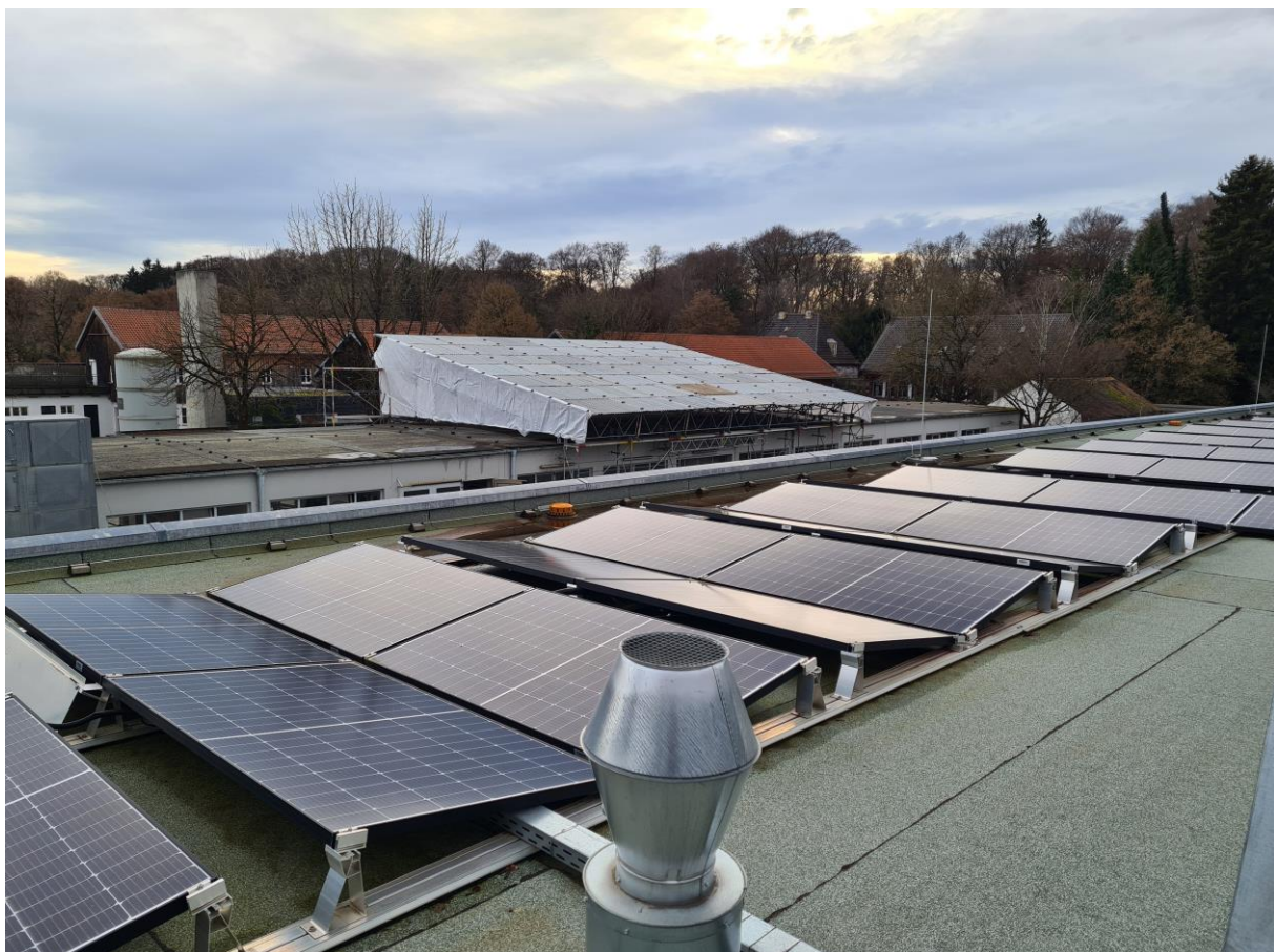
Neue Photovoltaikanlage auf dem Dach der neuen Werkstatt, alte Werkstatt im Hintergrund (mit Notdach), Bild: Anette Vedder
