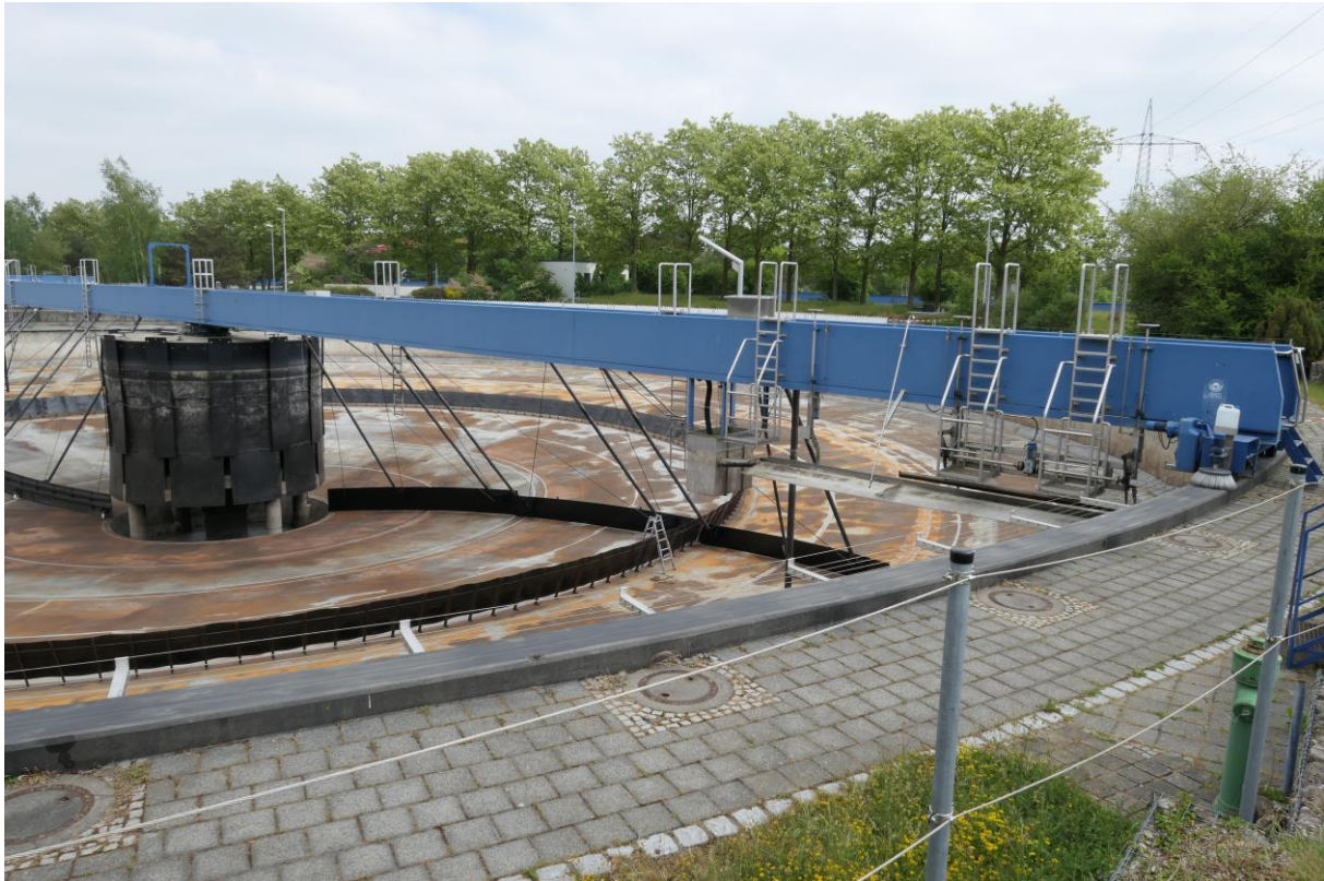
Eines von fünf Nachklärbecken in entleertem Zustand (Durchmesser 70 Meter). Bild: Klärwerk Augsburg
