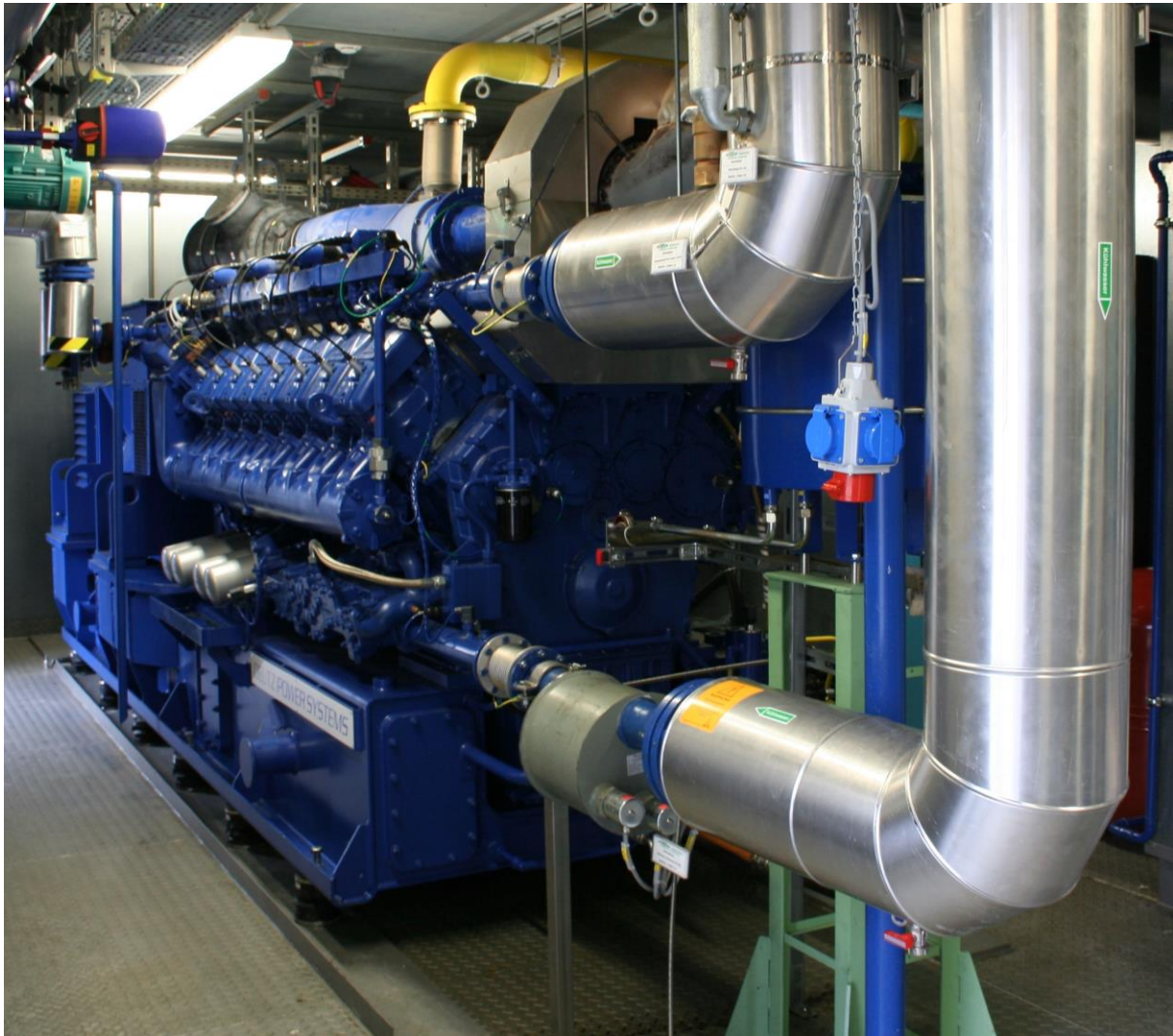
Eines von insgesamt drei Blockheizkraftwerken. Bild: Klärwerk Augsburg
