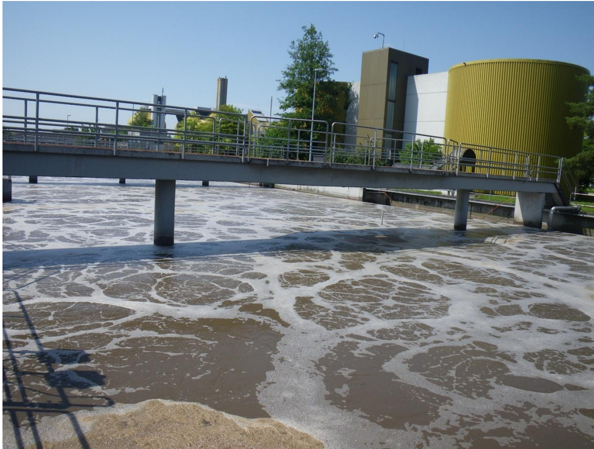
Kläranlage Augsburg, Bild: Stadtentwässerung Augsburg
