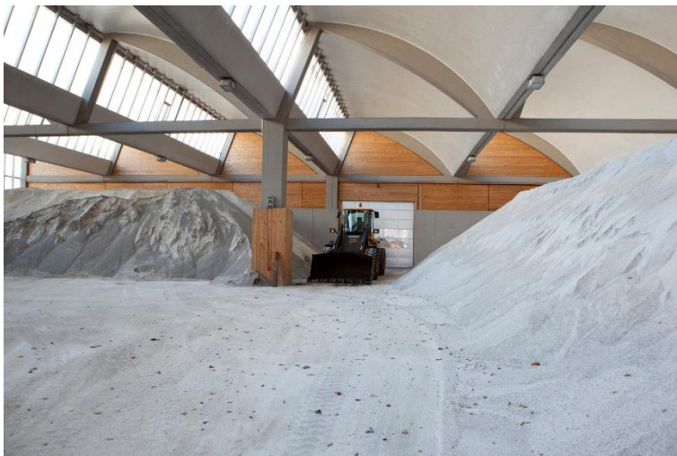
Salzlager im WSP Johannes-Haag-Straße, Bild: AWS, Archiv
