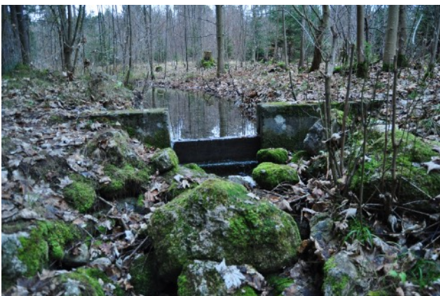
Alter Floßgraben (vor der Maßnahme)
