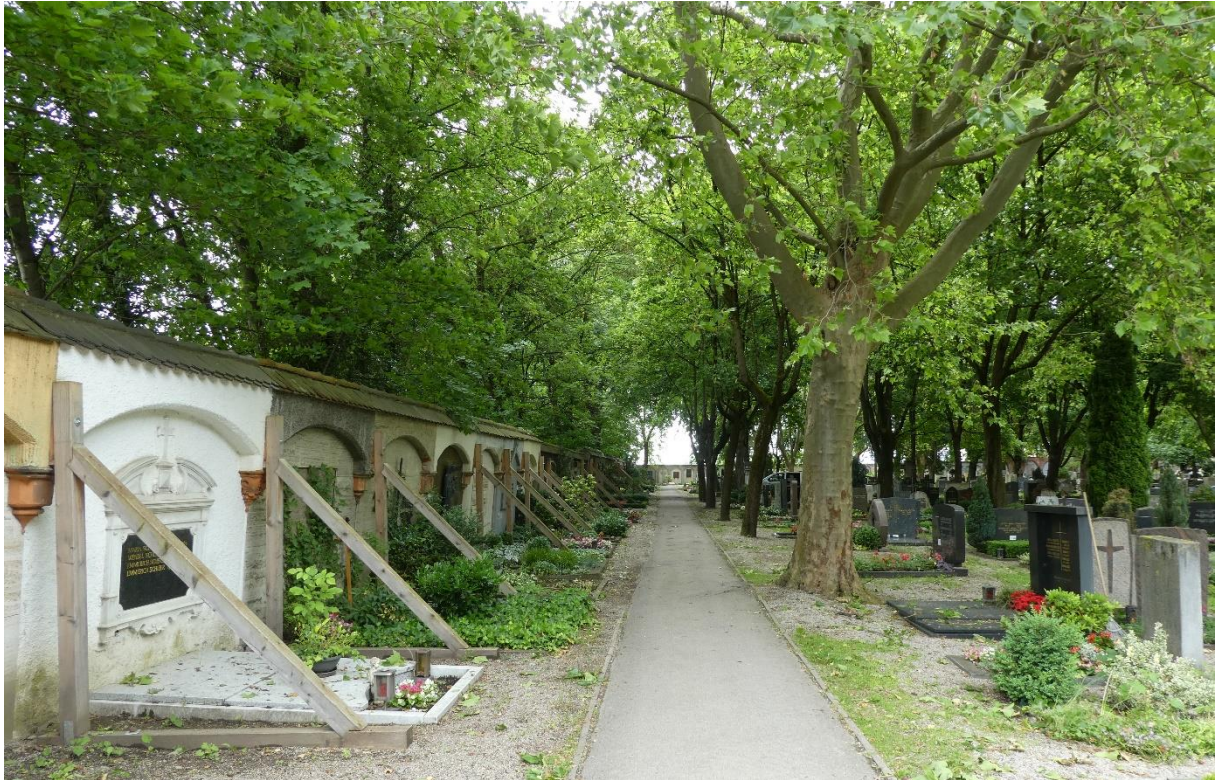
Im Hermannfriedhof Blickrichtung Westen; kritischer Baumbestand außerhalb (Stand 30.06.2021)
