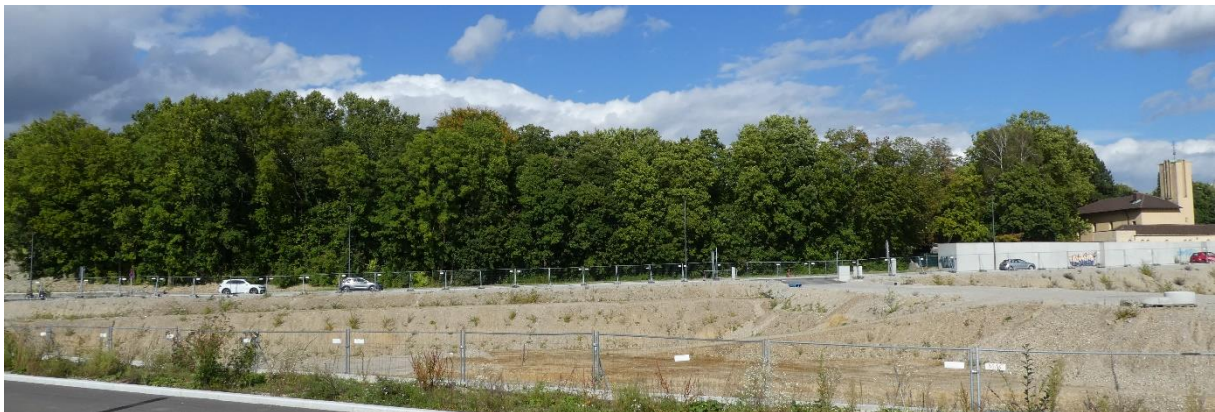
Ansicht des kritischen Baumbestandes von den Ladehöfen, Blickrichtung Norden (Stand 29.09.2021)
