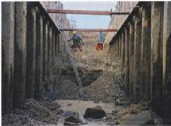
Aushub nach Grundwasserabsenkung
