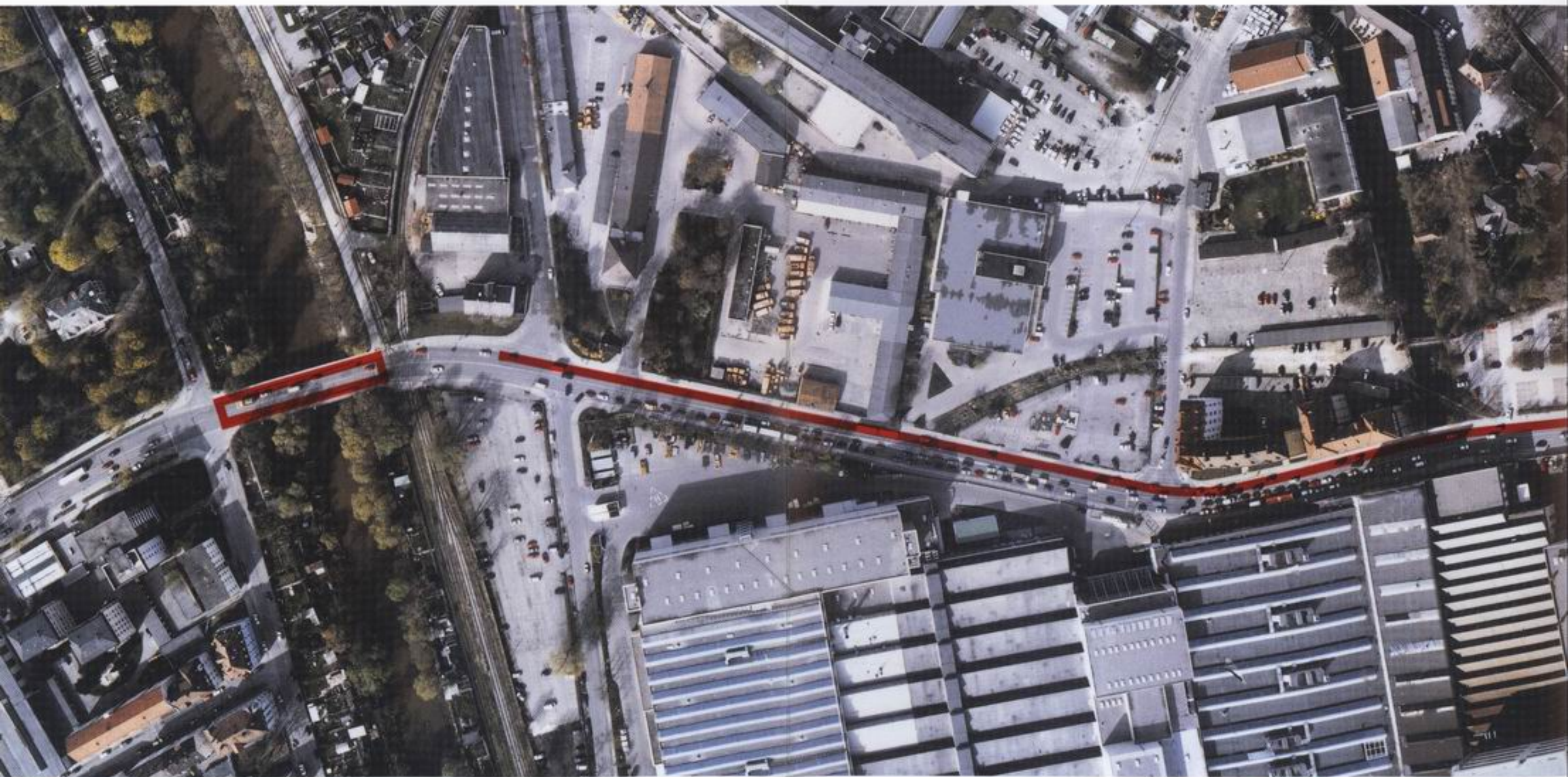
Neubau der Dieselbrücke
