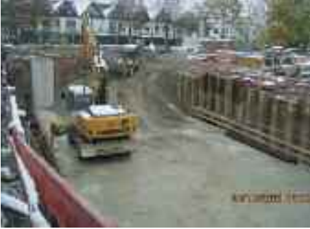
Verfüllen der Baugrube, Oktober 2012
