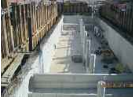
Betonarbeiten Spülstraße, September 2012
