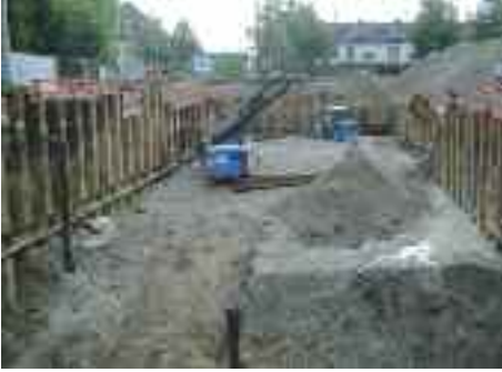
Verbau und Aushub, Juni 2012
