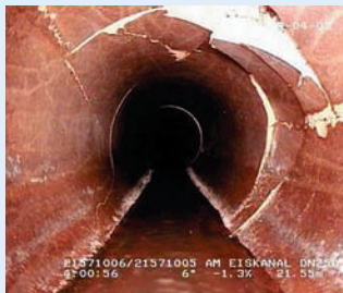
Kanal mit Scherbenbildung und Längsrissen
