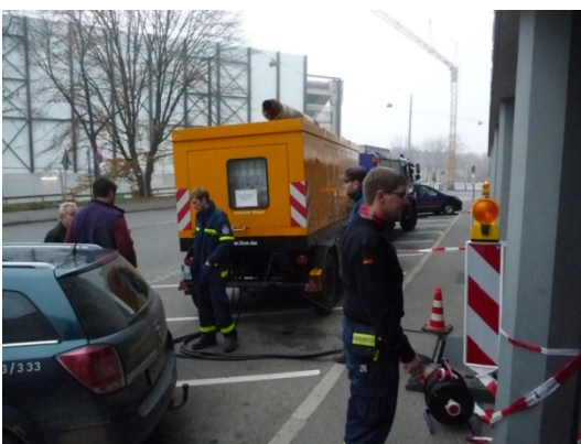
Mitglieder des THW beim Einsatz des Notstromaggregates vor dem Gebäude
