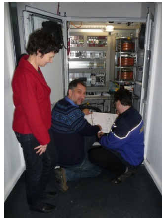
Renecost Spannungsregelanlage nach dem Einbau
