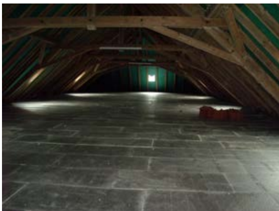
Dämmung der oberen Geschossdecke
