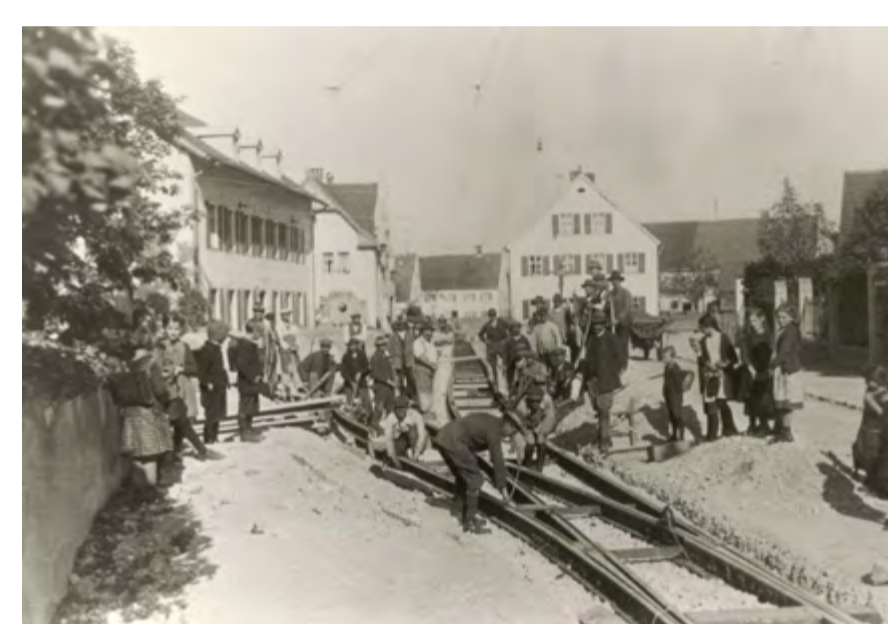
Einbau der Gleise am Georg-Käsl-Platz für die neue Straßenbahn, 1927
