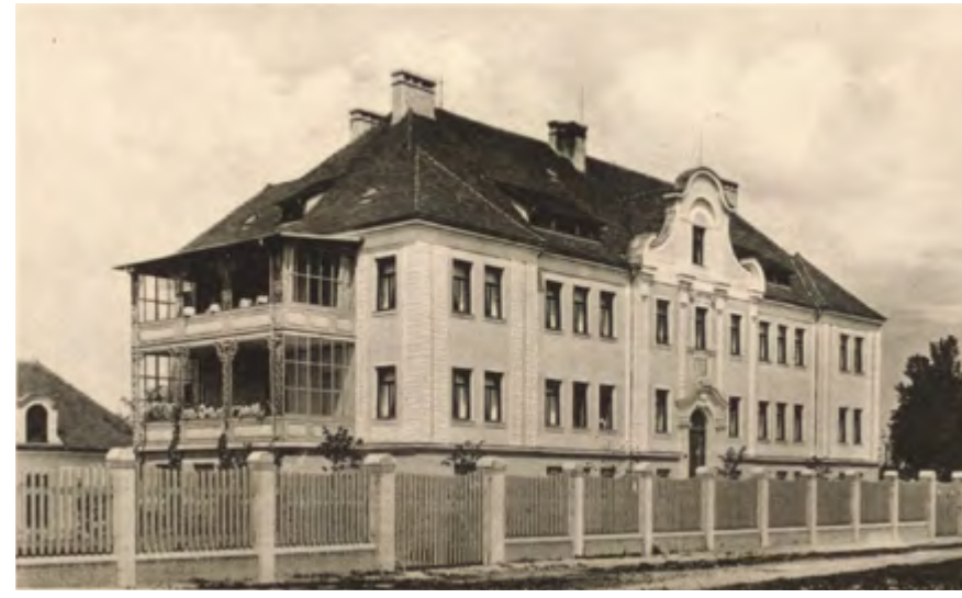
Seit 1903 sicherte das Krankenhaus die medizinische Versorgung der Gögginger. Nach der Eingemeindung wurde es bis zu seiner Schließung 1981 als Beleghaus weiterbetrieben, Postkarte um 1920.
