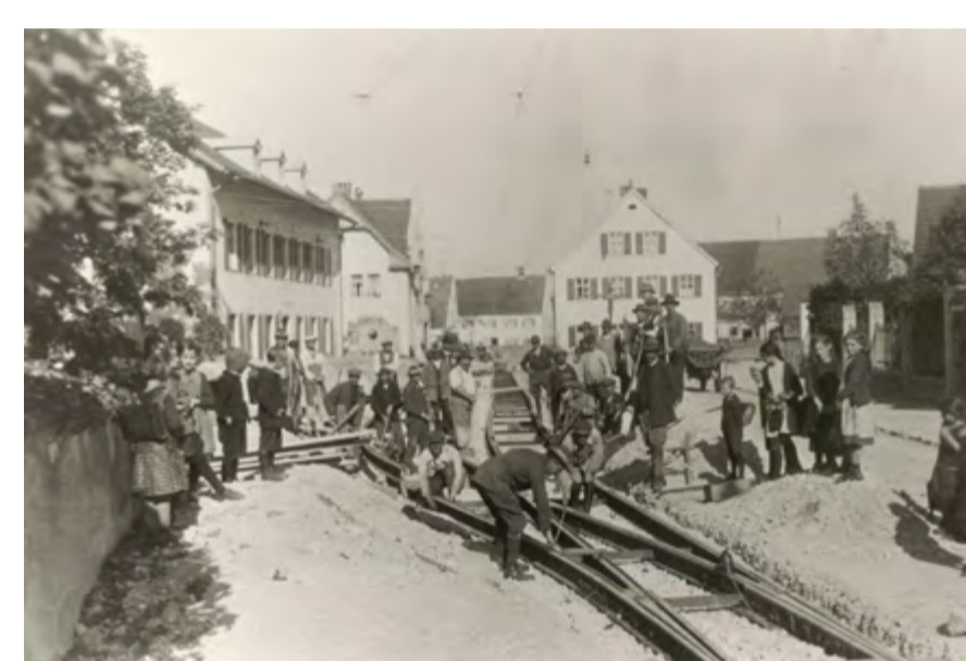
Einbau der Gleise am Georg-Käse-Platz für die neue Straßenbahn, 1927
