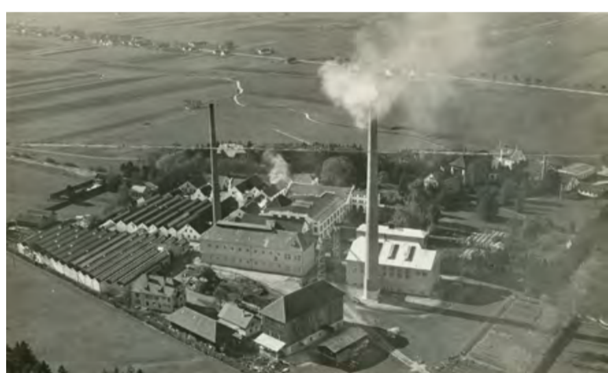
Gebäudekomplex der Firma Martini & Co., errichtet auf dem Areal der ehemaligen Weißbleiche. Luftbild, 1933
