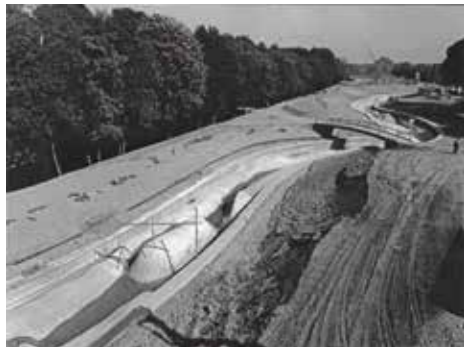
Kanustrecke im Rohbau, ca. 1971 (Foto: Nachlass Architekten Brockel & Müller, Augsburg)
