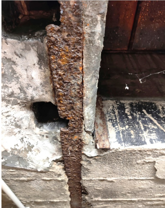
Korrosionsschäden - Stahlbetondecke
