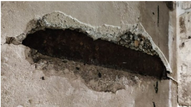
Korrosionsschäden - Stahlbetondecke
