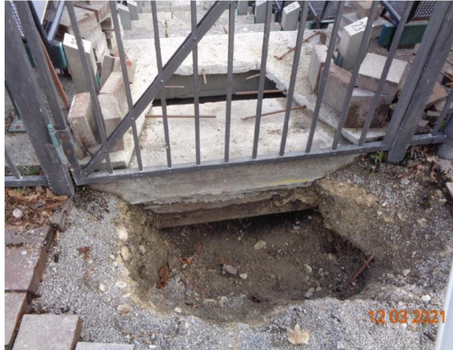
Fehlende Stützmauer- Bilder von Draußen/ Gehweg
