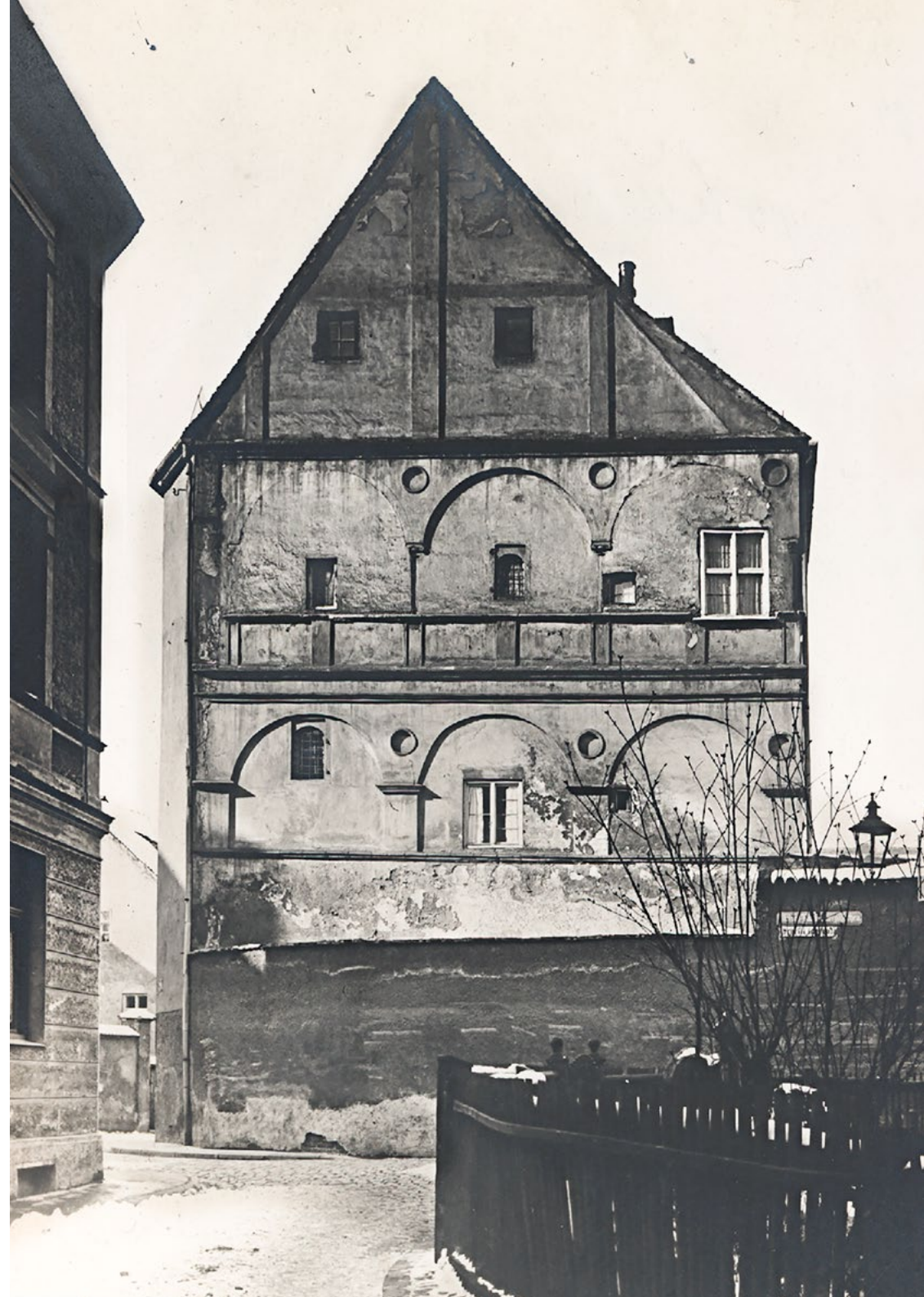
Sog. Wieselhaus, Giebelseite mit Arkadenbögen, Ansicht von Osten ►
