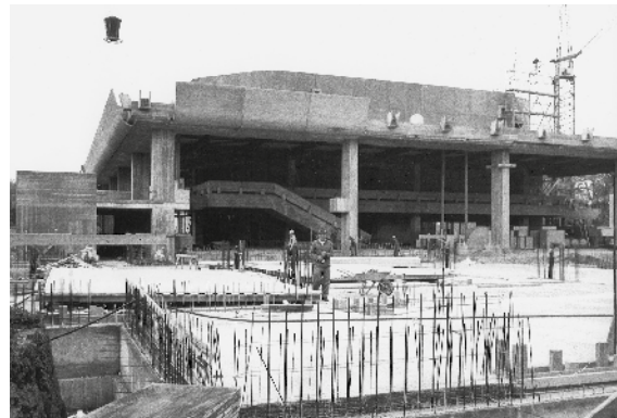
Kongresshalle im Bau, undatiert Quelle: Fred Schöllhorn
