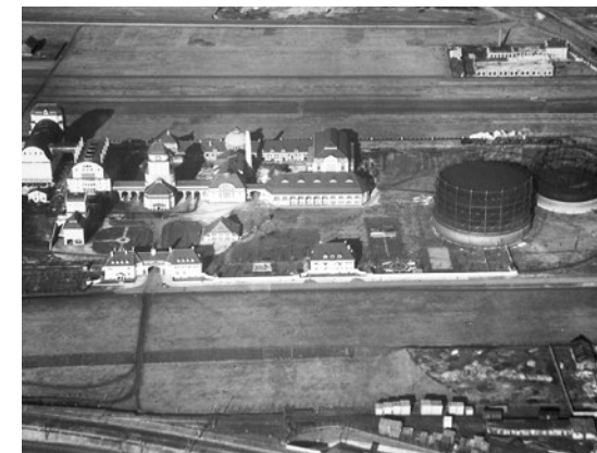
Gesamtanlage des Gaswerks, Luftbildaufnahme Quelle: Archiv Gaswerksfreunde Augsburg e. V.
