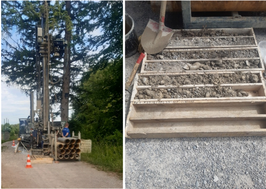
Erkundungsbohrung am Neuen Graben
