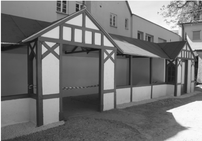
14.1.: Die Kegelbahn nach der Sanierung, Foto: Diakonie
