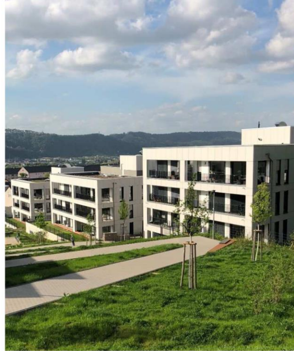
Trier, Castelnau - Fertigstellung 2017, 42 Wohnungen mit Tiefgaragen
