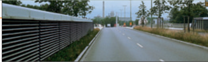
Maßnahme zum Schutz eines Wohngebiets in Form einer Schallschutzwand. Hier: Schleifenstraße in Lechhausen
