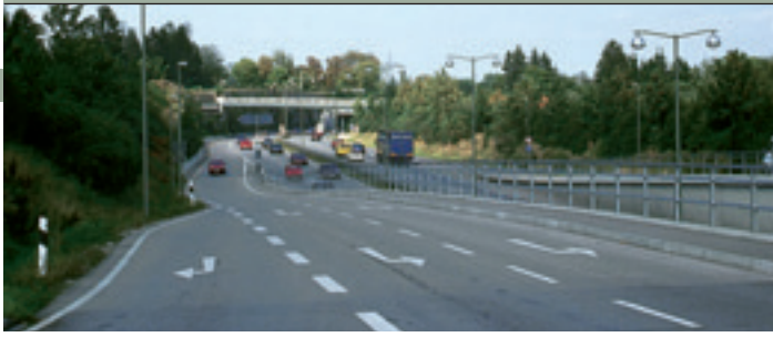
Höhenfreier Knotenpunkt der B17 am Kobelweg
