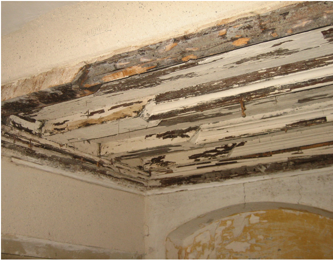
Holzbalkendecke vor der Restaurierung im Raum Erdgeschoss (Nebengebäude)
