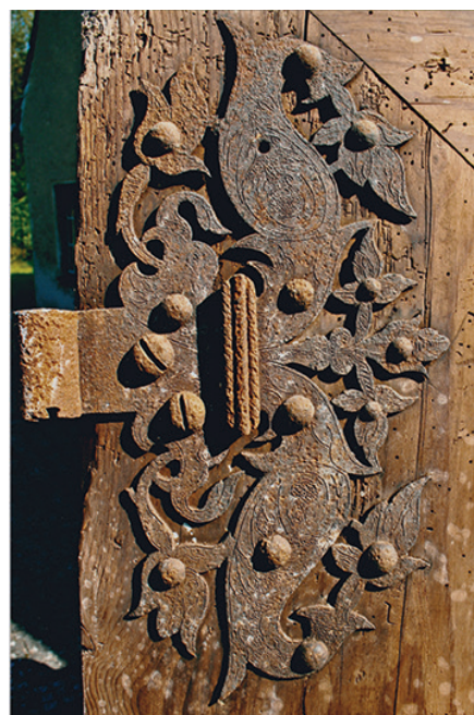
Asymmetrische Holzrahmentür mit außergewöhnlich schönen Beschlägen im Erdgeschoss (Nebengebäude)
