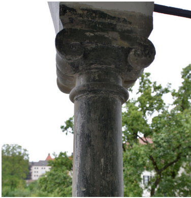
Kapitell in der Arkade im 2. Obergeschoss (Hauptgebäude)
