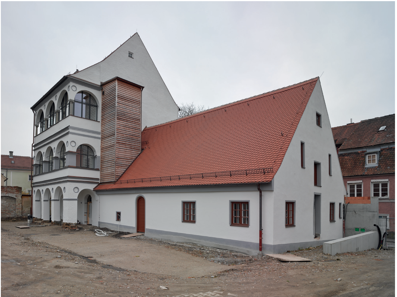
Blick von Nordwesten (auf Haupt- und Nebengebäude)
