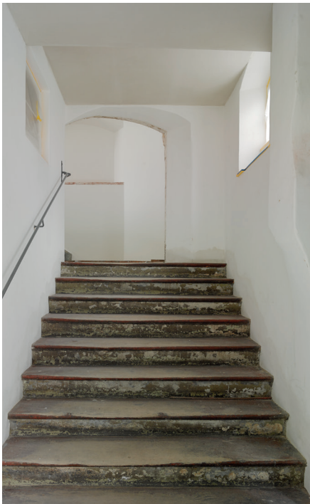
Treppe vom Erdgeschoss ins 1. Obergeschoss (Hauptgebäude)
