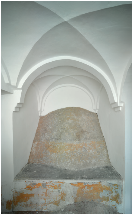
Gewölbe im Erdgeschoss mit Wölbung Kellerabgang (Nebengebäude)
