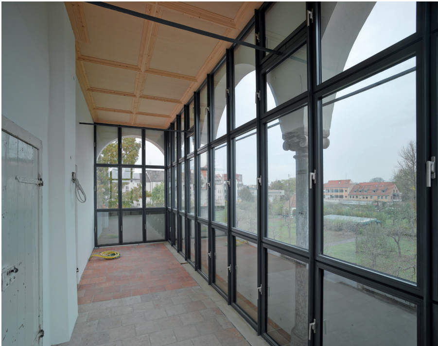
links von oben nach unten: Arkade 2. Obergeschoss (Hauptgebäude)
