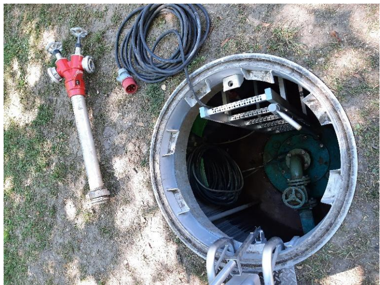
Abbildung 15; Brunnenschacht eines Notbrunnens
