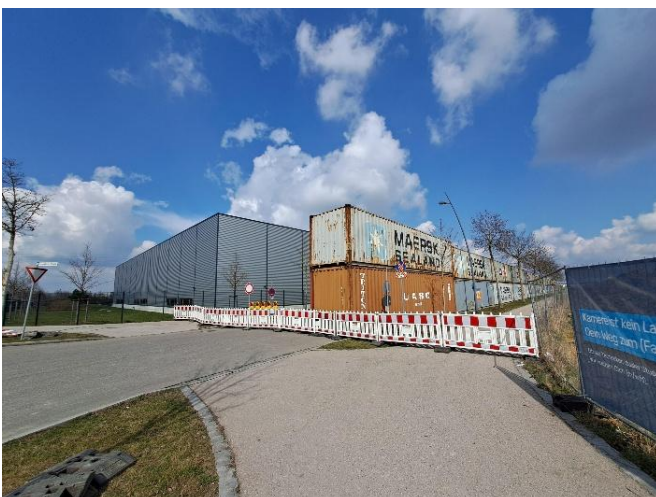
Abbildung 19; Containerwall zum Schutz eines Firmengeländes
