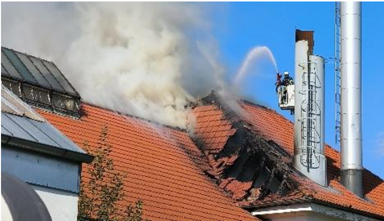
Abbildung 9: Dachstuhlbrand in Göggingen.
