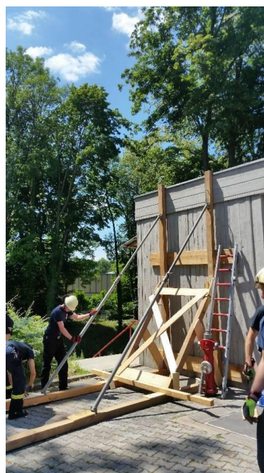
Grundausbildungslehrgang: Abstützarbeiten an einer einsturzgefährdeten Wand
