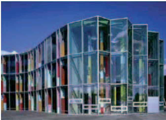
Technologiepark Berlin Adlershof
