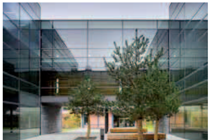
Öffnung im Erdgeschoss, Forschungszentrum Ulm
