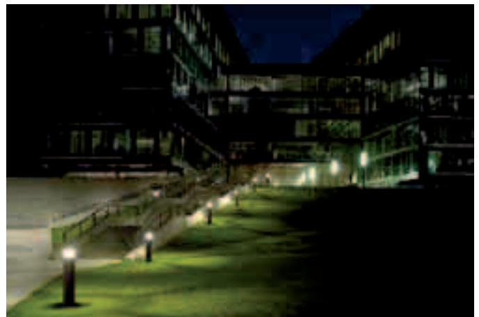
Pollerleuchten, Digitalpark Bratislava
