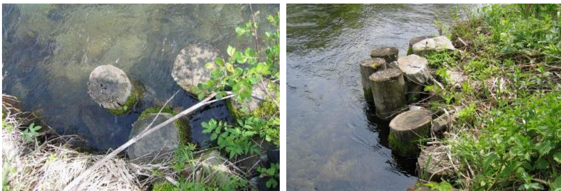
Abbildung 29: Holzpfähle als Strukturgeber (Fotos: Revital)
