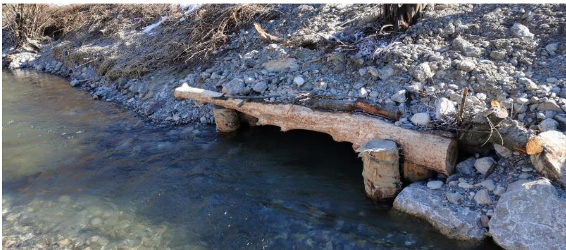
Abbildung 39: Fischeinstand aus Raubbäumen und Holzpfählen, Schlitterer Gießen (Foto: Revital)
