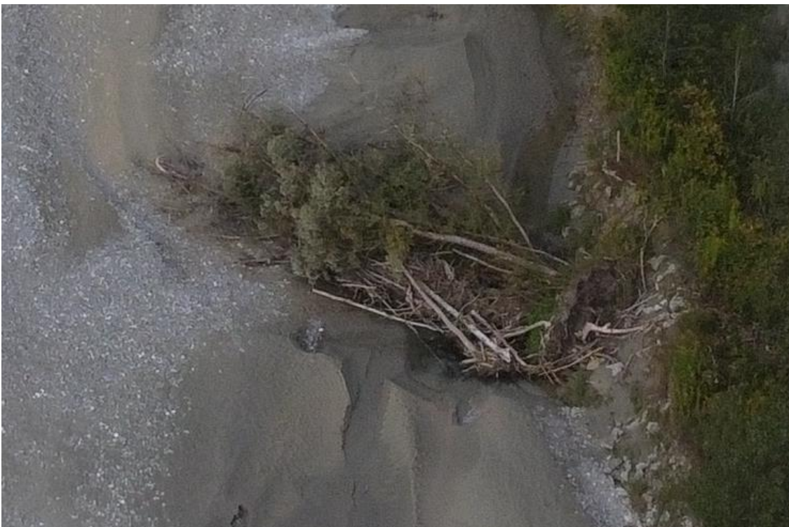
Abbildung 46: Raubbaumhaufen im Bereich einer Vorlandabsenkung, im Hochwasserfall umströmt (Foto: Revital)
