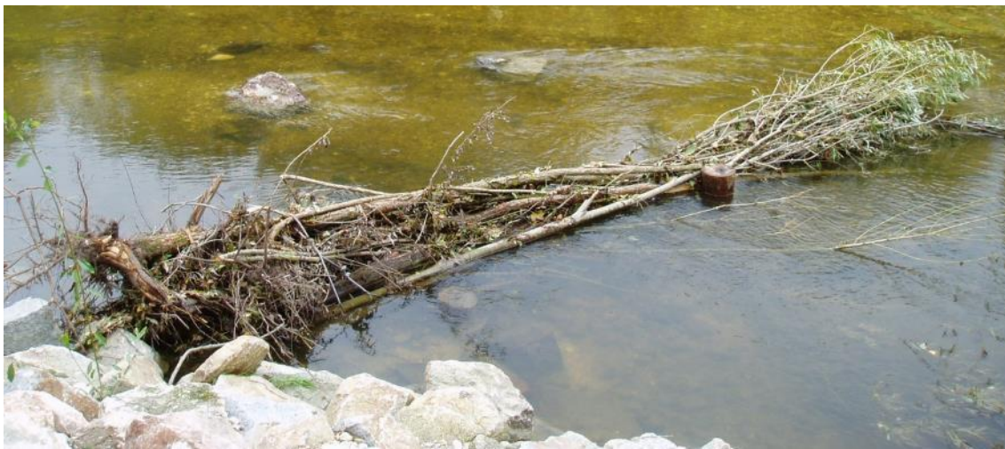
Abbildung 14: Raubaumbuhne in der Traisen/NÖ (Quelle: Flussbau und Ökologie, 2014)
