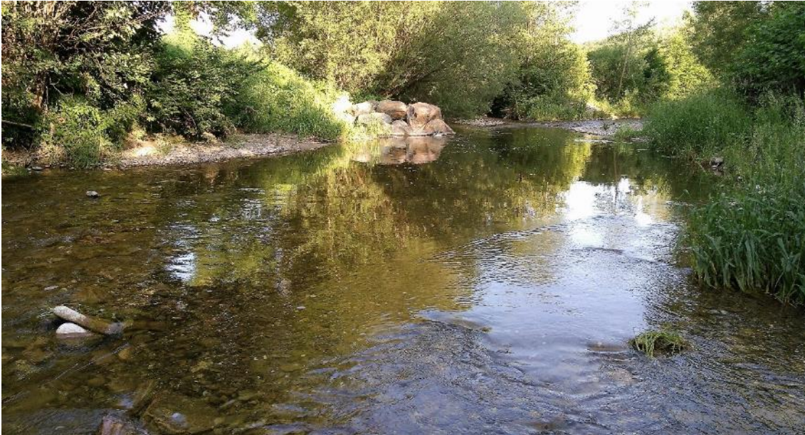
Abbildung 31: Bühnen als Instream-Strukturgeber, bei entsprechender Anordnung entsteht eine variable Sohlausformung mit Kolk-Furt-Abfolge (Foto: Martin Mühlbauer, ezb)
