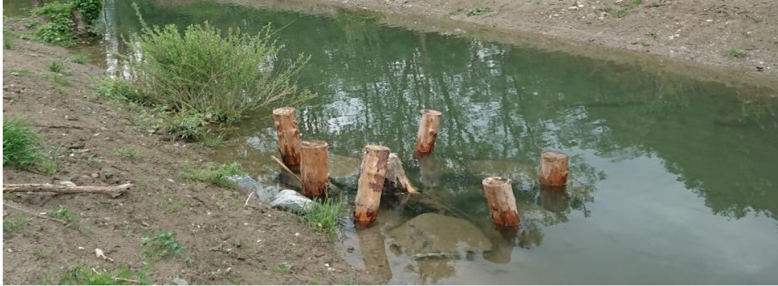
Abbildung 16: Holzpfähle in Kombination mit Wasserbausteinen und Wurzelstöcken am Ufer, Nebenarm Möll (Foto: Revital)
