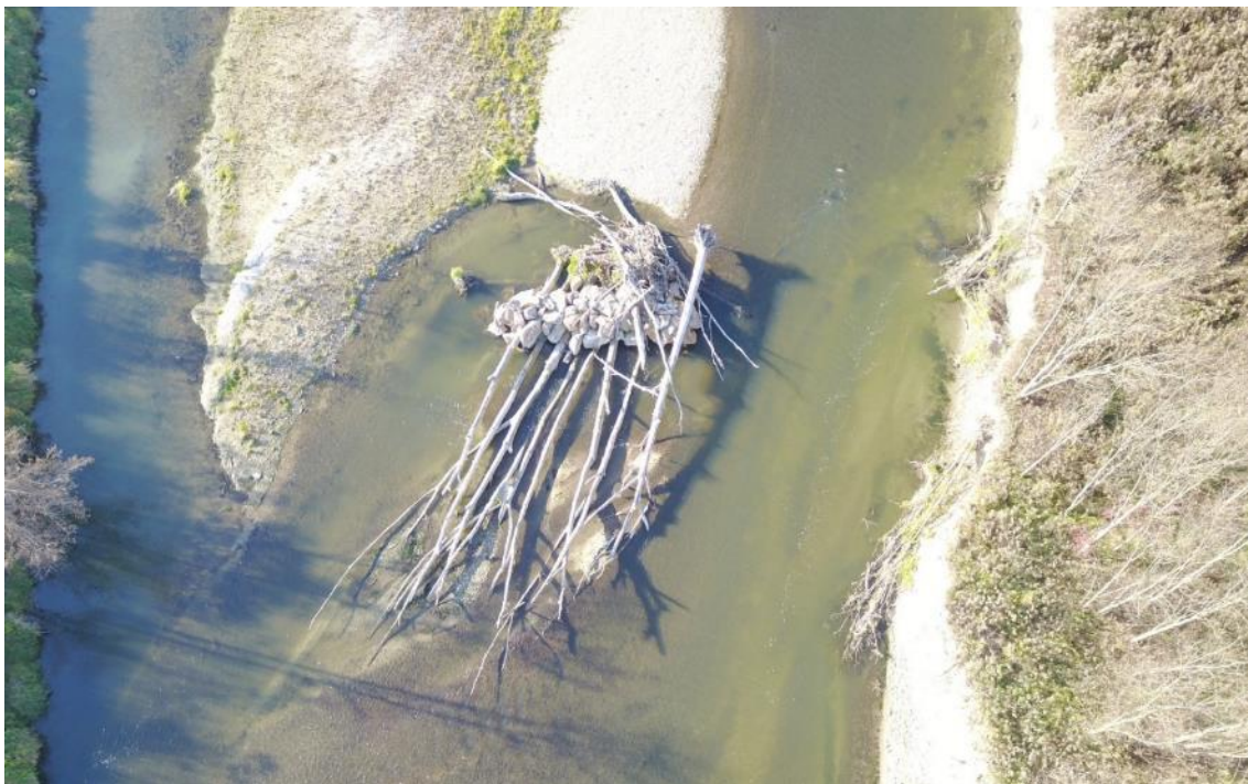
Abbildung 25: Parallel verlegte Raubäume mit Wasserbausteinen in Gerinnemitte fixiert inkl. angetriebenem Totholz (Foto: ezb TB Zauner)
