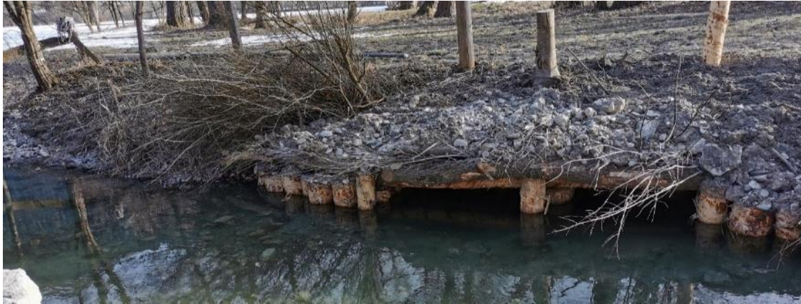
Abbildung 38: Fischeinstand aus Raubbäumen und Holzpfählen, Schlitterer Gießen (Foto: Revital)
