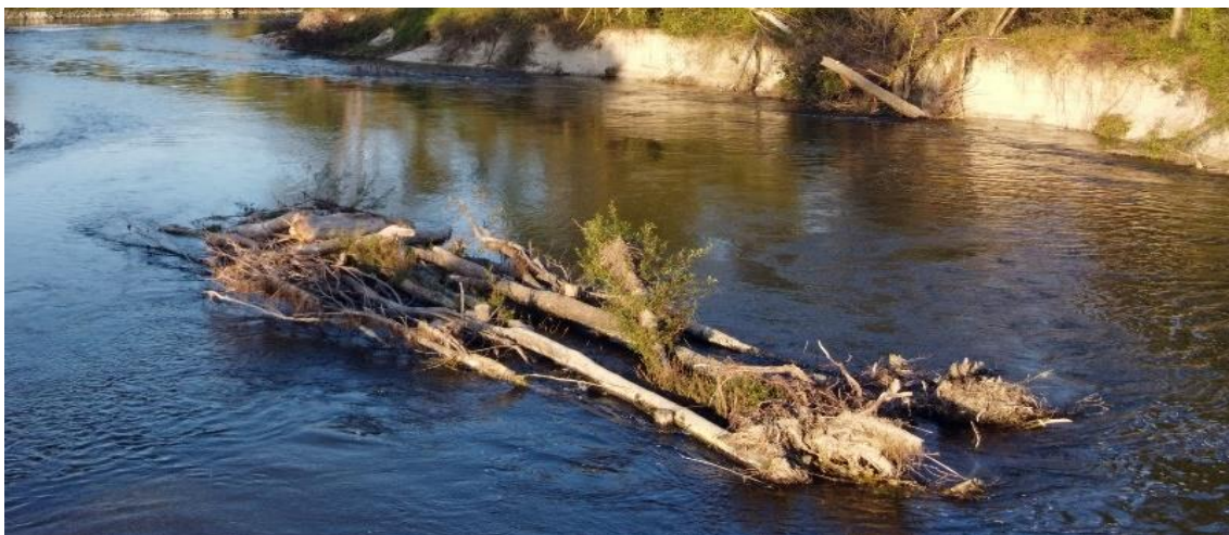
Abbildung 23: Raubäume mit Holzpfählen fixiert Strömungsteiler und Strukturgeber in Gerinnemitte (Foto: ezb TB Zauner)
