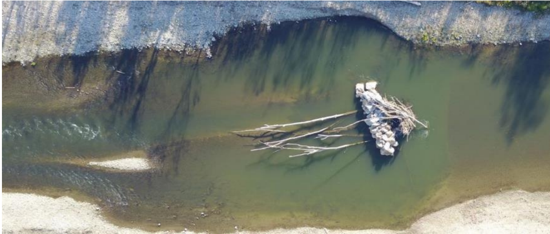
Abbildung 47: Strömungsteiler bestehend aus Raubäume mit Wasserbausteinen kombiniert als Strömungsteiler und Strukturgeber (Foto: Martin Mühlbauer, ezb)
