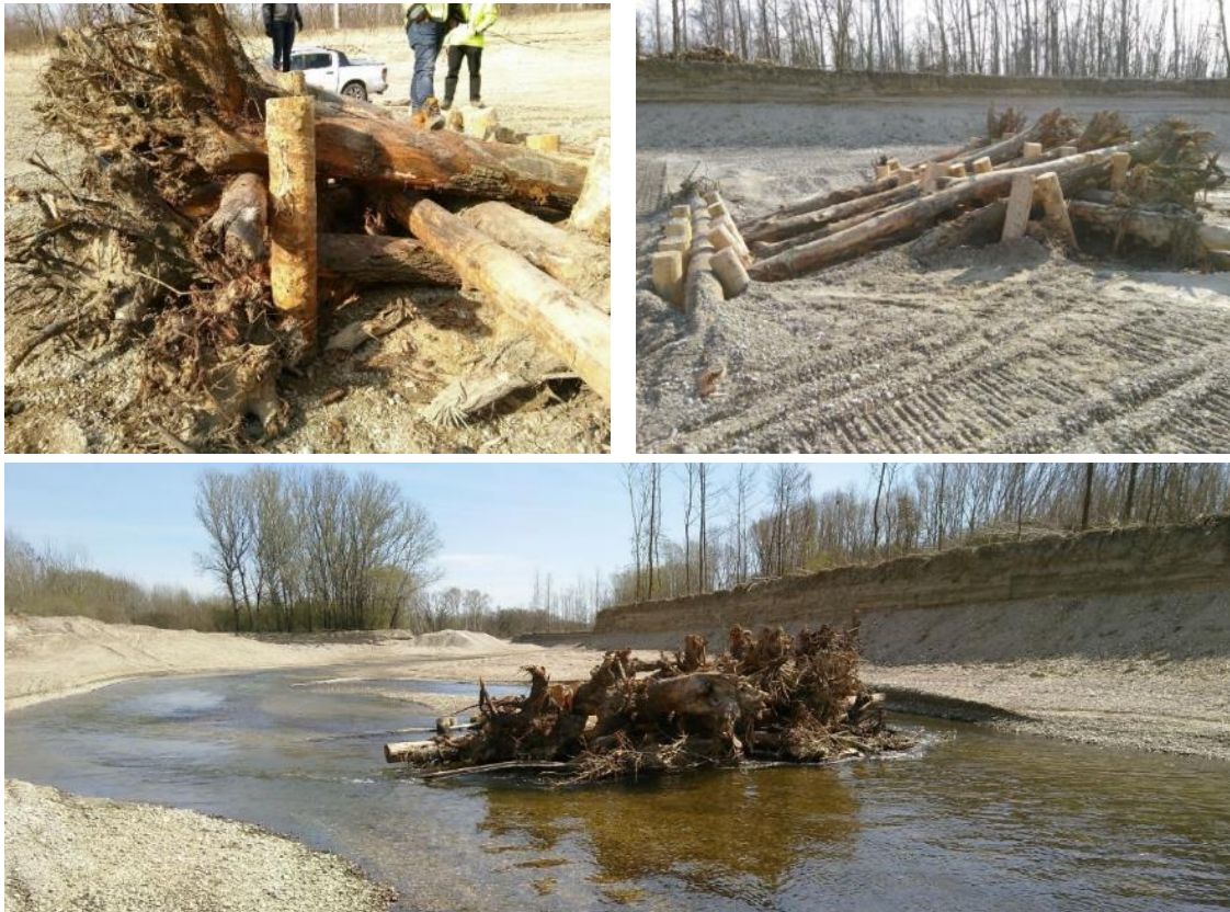
Abbildung 22: Raubaumstruktur im Bauzustand (Bilder oben) und nach erfolgter Umsetzung (Fotos: ezb TB Zauner)
