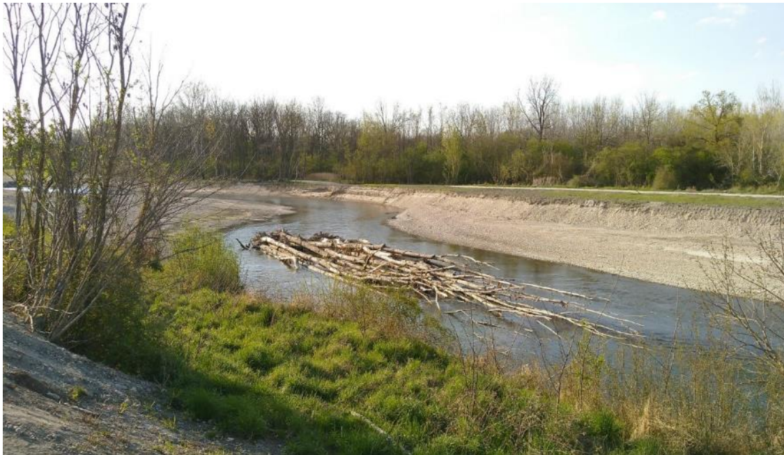
Abbildung 24: Parallel verlegte Raubäume als Strukturgeber in Gerinnemitte (Foto: ezb TB Zauner)
