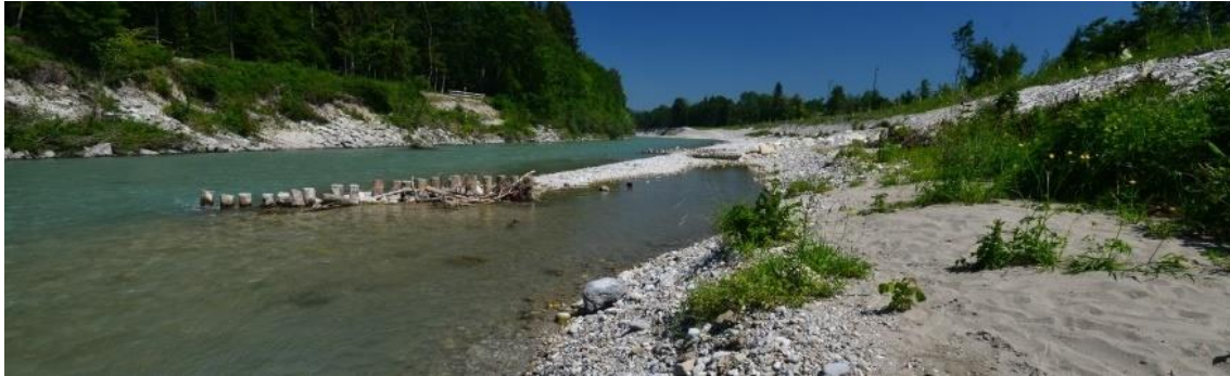
Abbildung 13: Raubaumbuhne mit Totholzrechen, Salzach (Foto: Revital)
