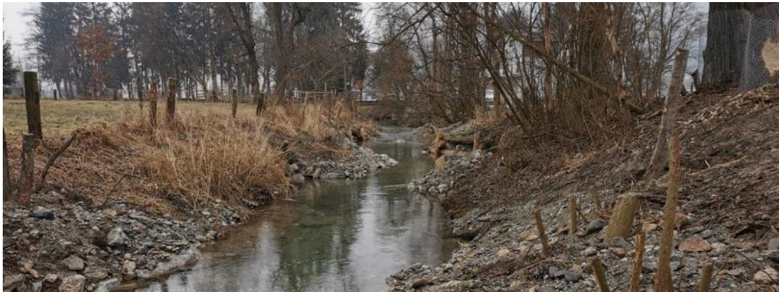
Abbildung 42: Geschiebeschüttungen, um ein Pendeln im Abflussprofil zu initiieren (Foto: Revital)
