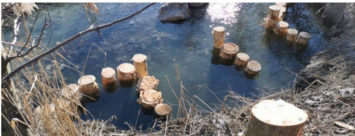
Abbildung 40: Fischeinstand im Bauzustand, Schlitterer Gießen (Foto: Revital)
