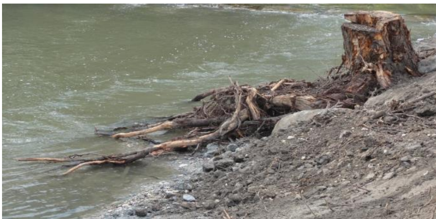
Abbildung 20: Raubaum und Wurzelstöcke am Ufer der Drau, HWS Sillian (Foto: Revital)
