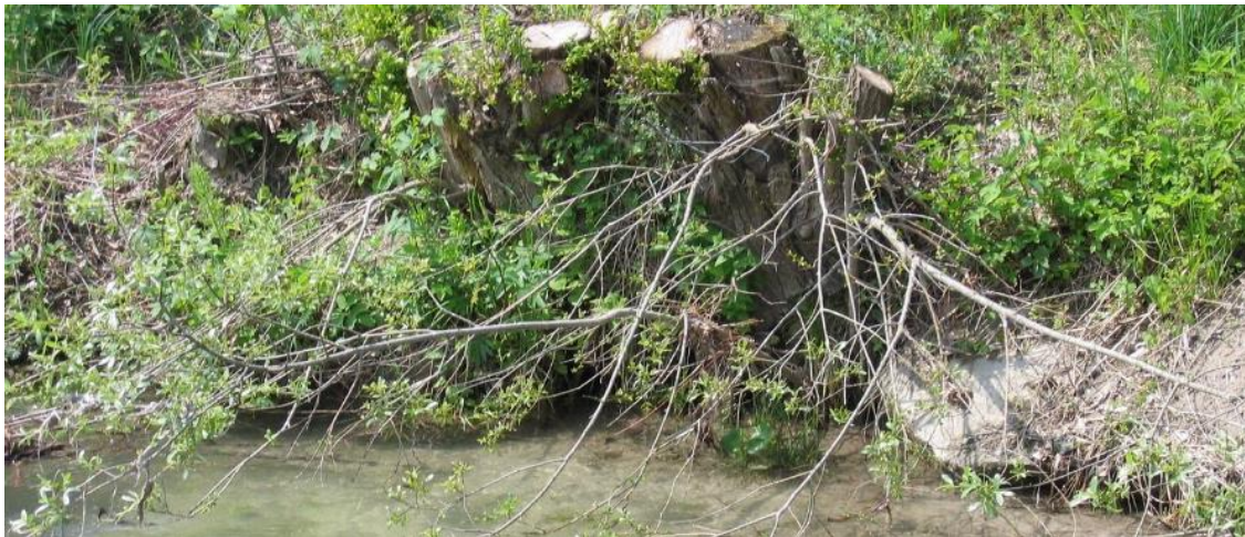
Abbildung 35: Ausschlagende Wurzelstöcke an der Wasseranschlaglinie eingebracht (Foto: Revital)
