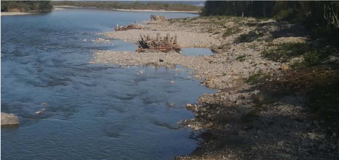
Abbildung 45: Strömungsteiler aus Holzpfählen, Wurzelstöcke, Raubäumen im Mündungsbereich der Bregenzer Ache (Foto: Revital)
