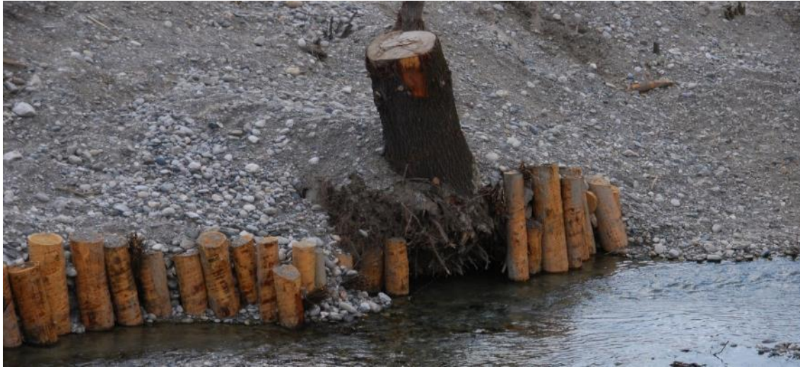
Abbildung 34: Wurzelstock als Fischeinstand, kombiniert mit Holzpfählen (Foto: Revital)
