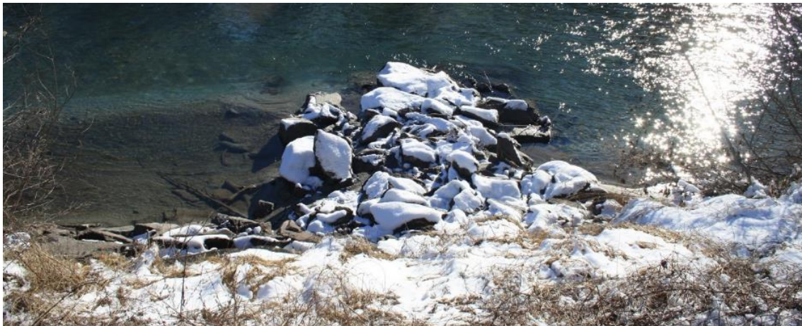
Abbildung 11: Kurzbuhne aus Wasserbausteinen, Drau in Kärnten (Foto: Revital)
