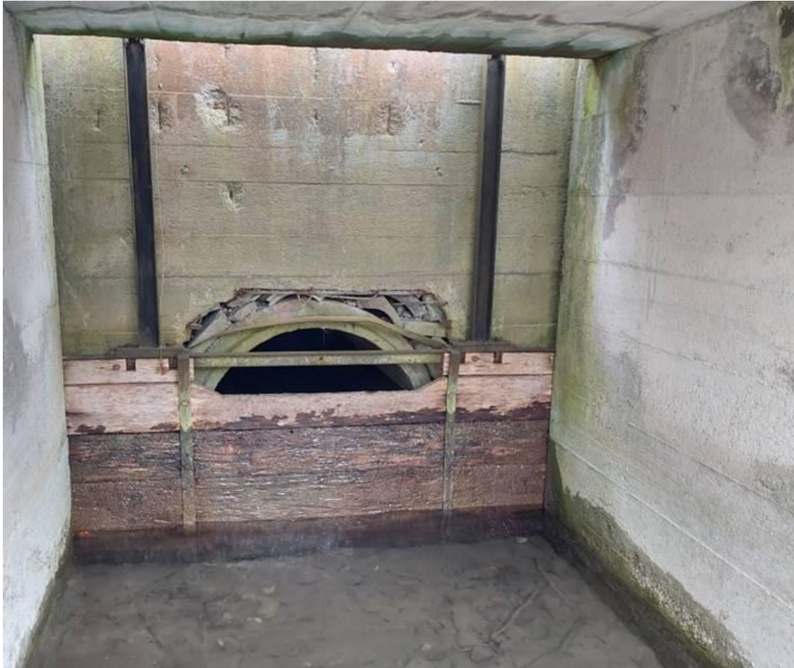
Abbildung 2.10: Bestehendes Überfallwehr am Weitmannsee
