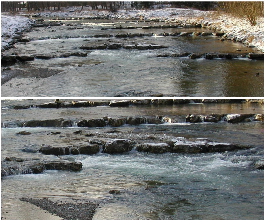
Abbildung 27: Beispiel für Typ 2, Sohlrampe an der Mangfall (Fotos: Hengl, BAW, Wien)
