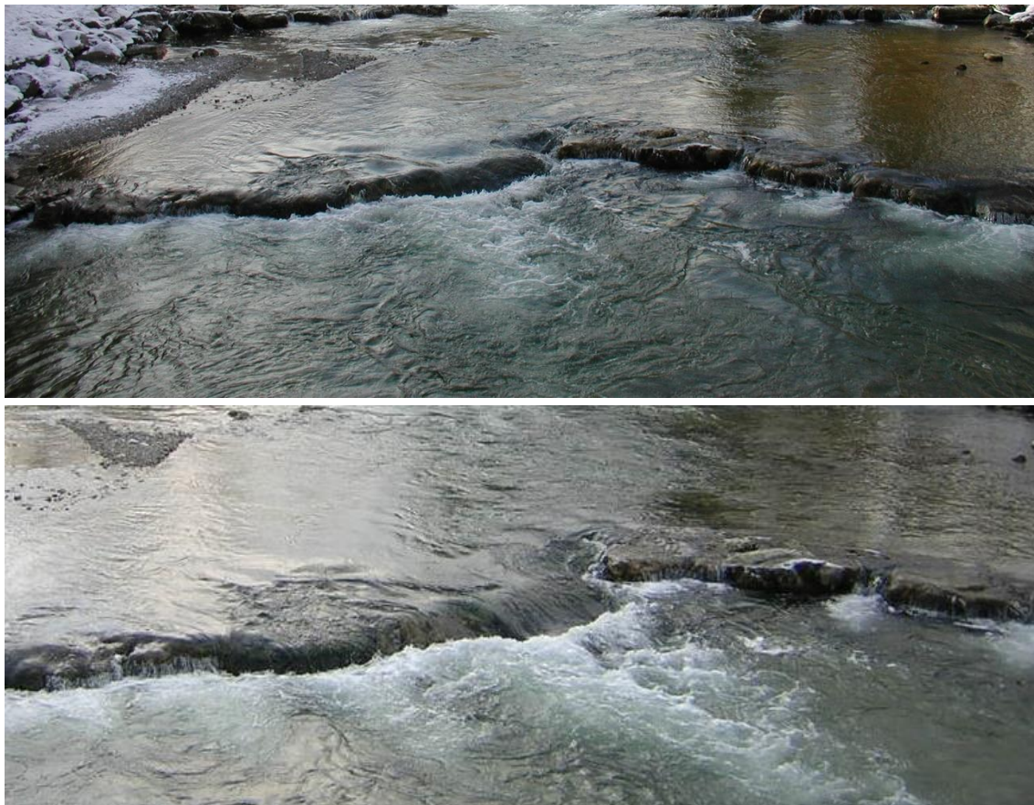
Abbildung 30: Beispiel für Typ 4, Sohlrampe an der Mangfall (Fotos: Hengl, BAW, Wien)
