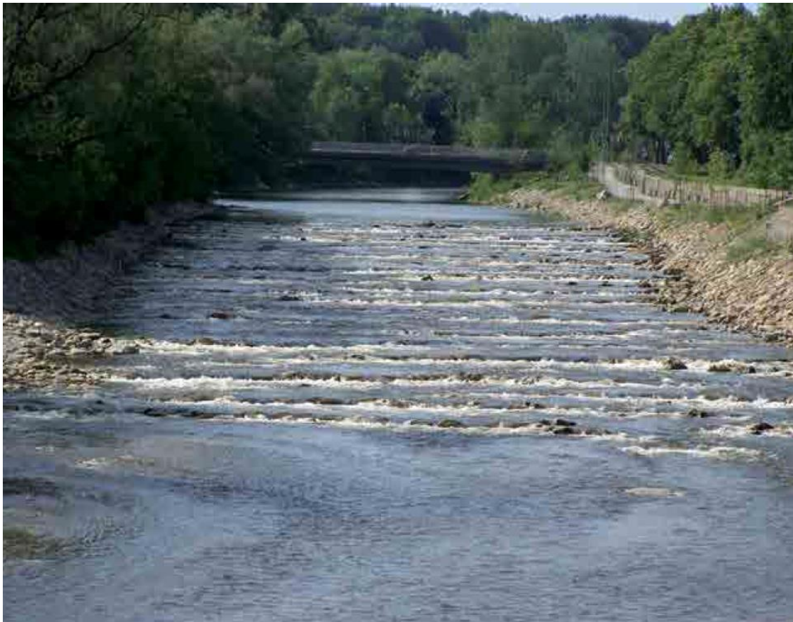
Abbildung 25: Beispiel Riegelrampe an der Wertach (ehemaliges Goggeleswehr, aus [15])
