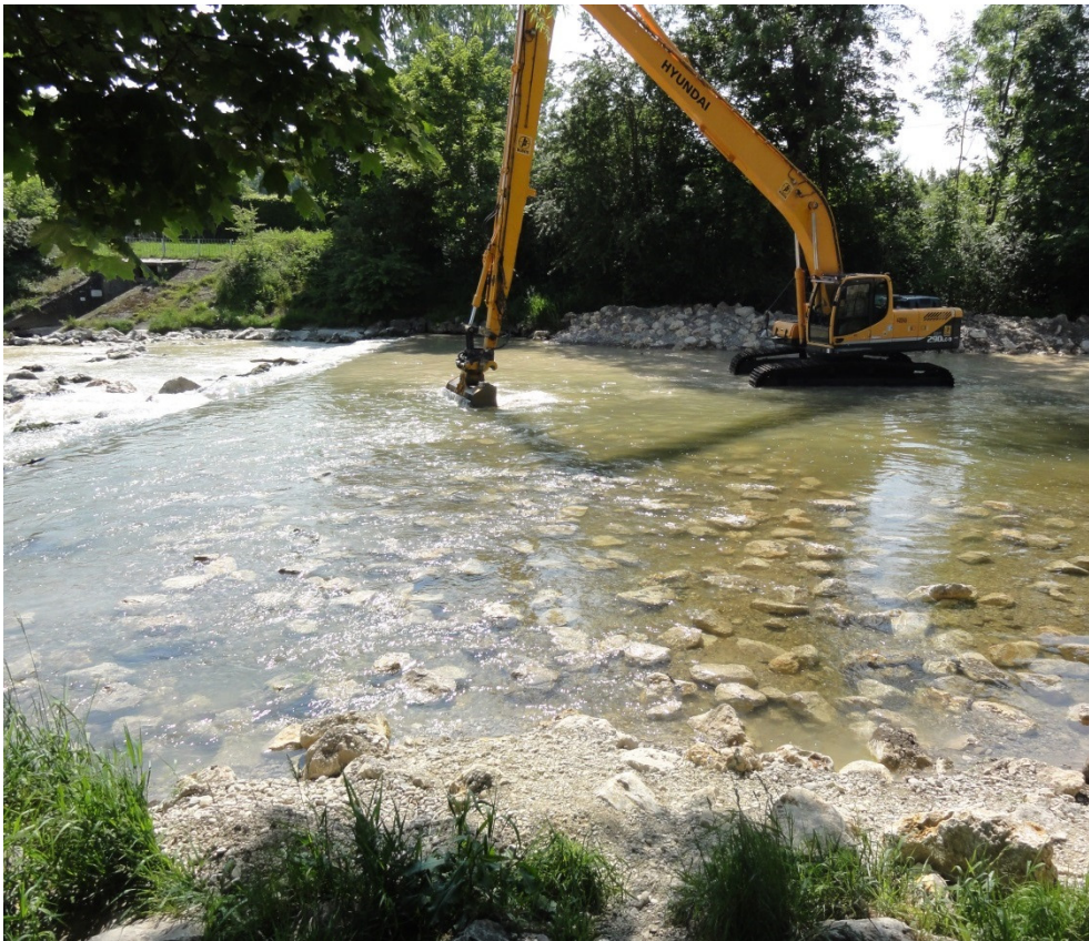
Abbildung 7: Verlegung des Offenes Deckwerks im 3.RA (ca. Fl.km 6+700)
