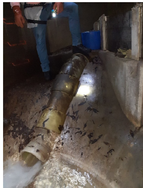
Abb. 2 In Schacht 20588035/20588011:Auslauf GW-Leitung in den Auslasskanal . Oben sichtbar die Außenseite der Überlaufschwelle
