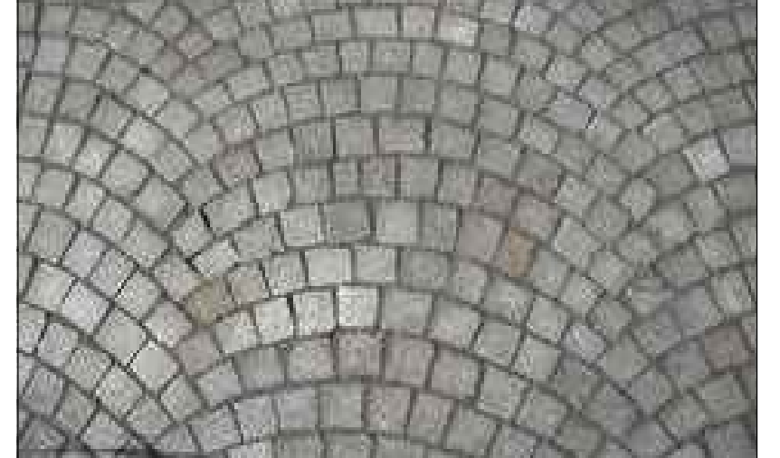
Granitkleinsteinpflaster, Segmentbogen, gesägt
