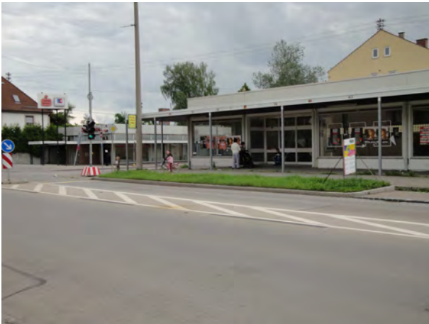
Foto 20: Zugspitzstraße Nr. 68/vormals Tengelmann
