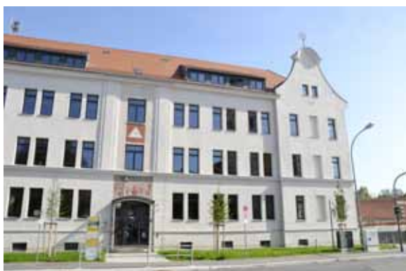
62 Die Eichendorff-Schule wurde erneuert und erstrahlt in neuem Glanz
