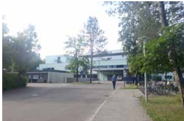
67 Eingang und Zufahrt zum Klinikum
