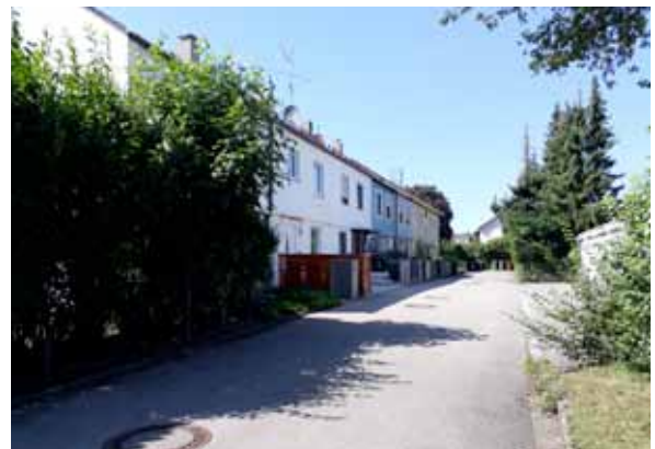
51 oben: Mehrfamilienhaus der mittleren Kategorie. Dach, Fassade, Fenster sind mittelfristig sanierungswürdig
