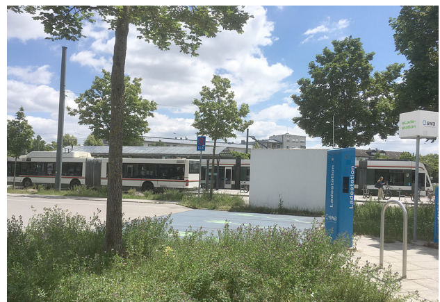
Ladestation für Elektroautos an der Inninger Straße
