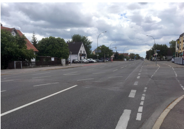
Trennwirkung der B17alt
