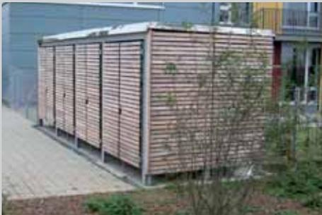
Mülltonneneinhausung aus Stahlkonstruktion mit Holzlamellen
