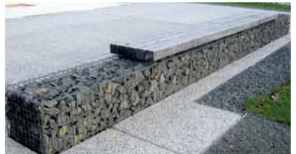
Gabione (Drahtkorb mit Steinfüllung) mit Sitzbank
