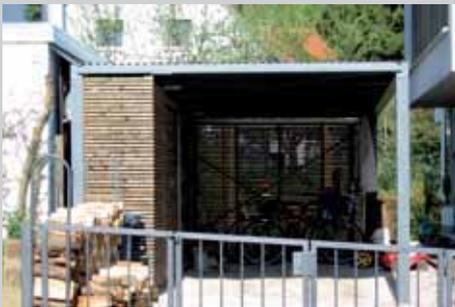
Carport als leichte Stahlkonstruktion mit Holzlamellen
