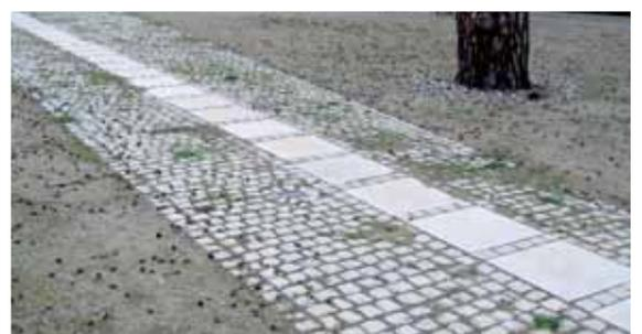
Kiesdecke, Natursteinpflaster, Betonplatten
