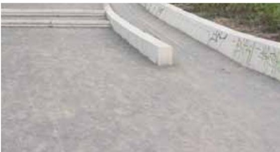
wassergebundene Decke mit Betonstufen und -kanten
