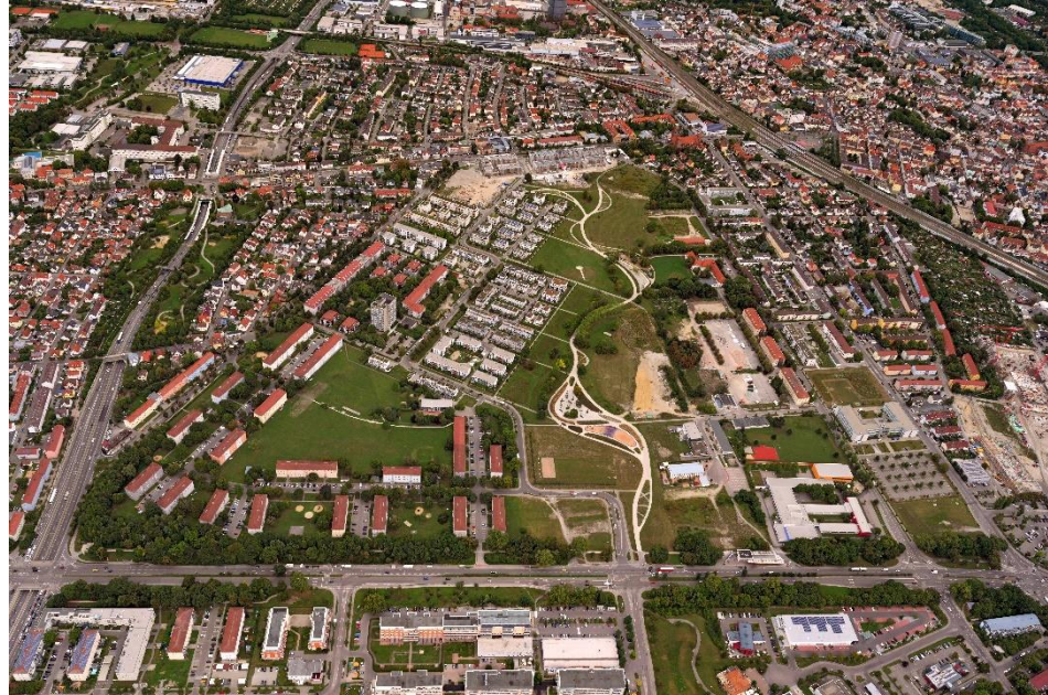
Luftbild Reesepark mit Blick nach Norden (August 2020)
