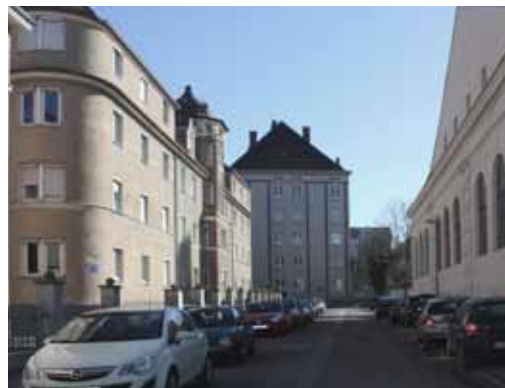
Allgemeine Baugenossen- schaft für Augsburg, Erste errichtete Wohnanlage
