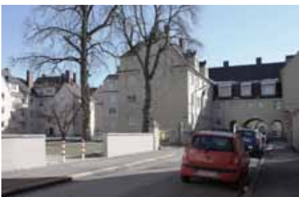
Allgemeine Baugenossenschaft Augsburg/ Wiesenstraße
