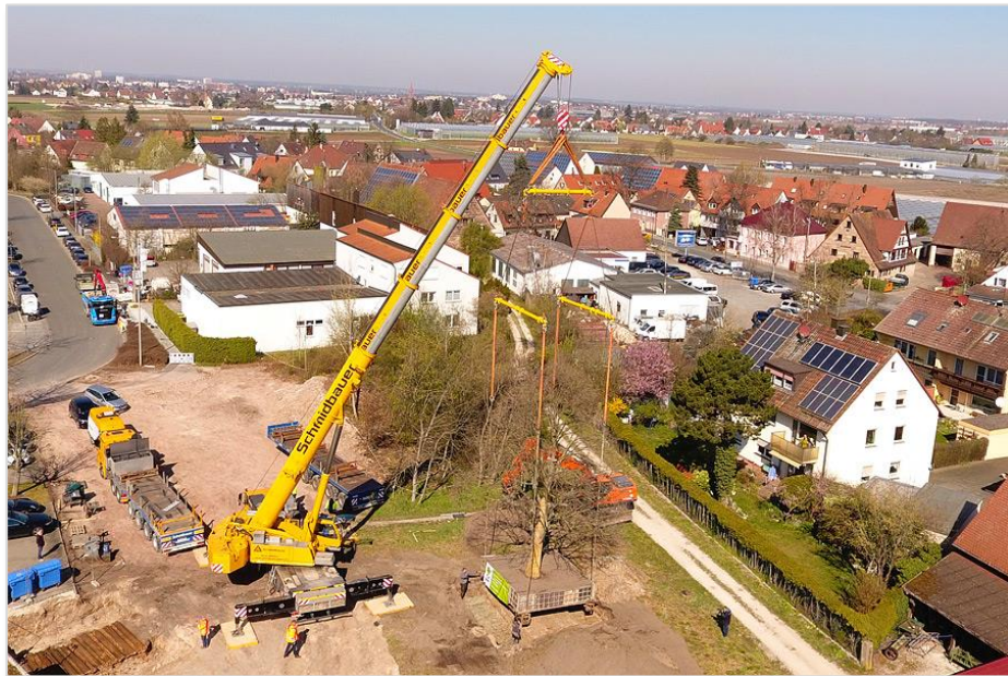
Abb. 46 Großbaumverpflanzung mittels Unterpressung und Kran (Quelle Fa. Opitz)
