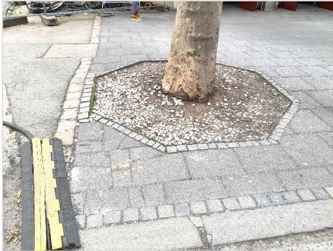
Abb. 38 Standort Vorbereich Zugang Empfangshalle, Baum Nr. 61625
