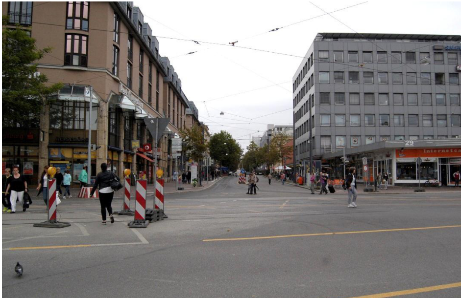
Foto Übergang Viktoriastraße - Bahnhofstraße vom Bahnhofplatz
