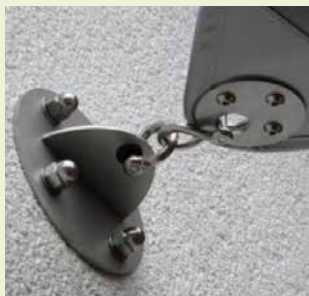
Befestigung an Fassaden mit Stahlscheibe
