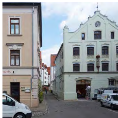
Wohnhaus, III. Quergäßchen 2
