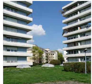
Wohnanlage Rauwolfstr. / Parcel- susstr.
