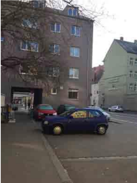
Wohnbebauung an der Pilgerhausstraße
