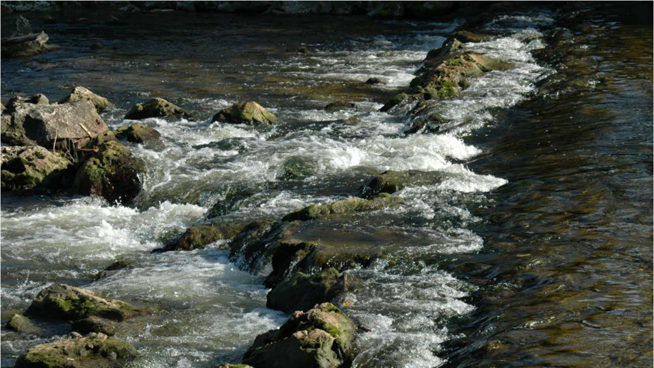
Sohlschwellen in der Wertach Quelle: Herwarth + Holz, Berlin
