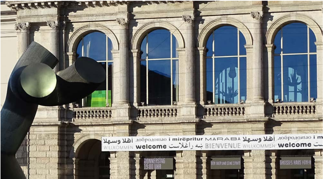
Denkmalgeschützte Fassade des Stadttheaters mit der Skulptur "Ostern" am Kennedy-Platz
