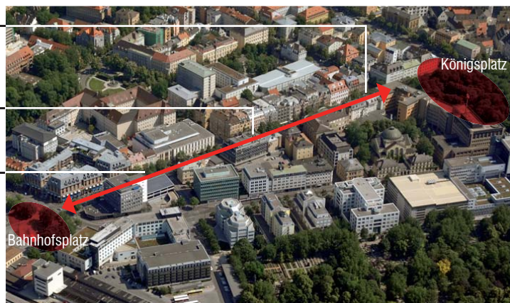
Bild: Städtebauliche Missstände in der Bahnhofstraße
