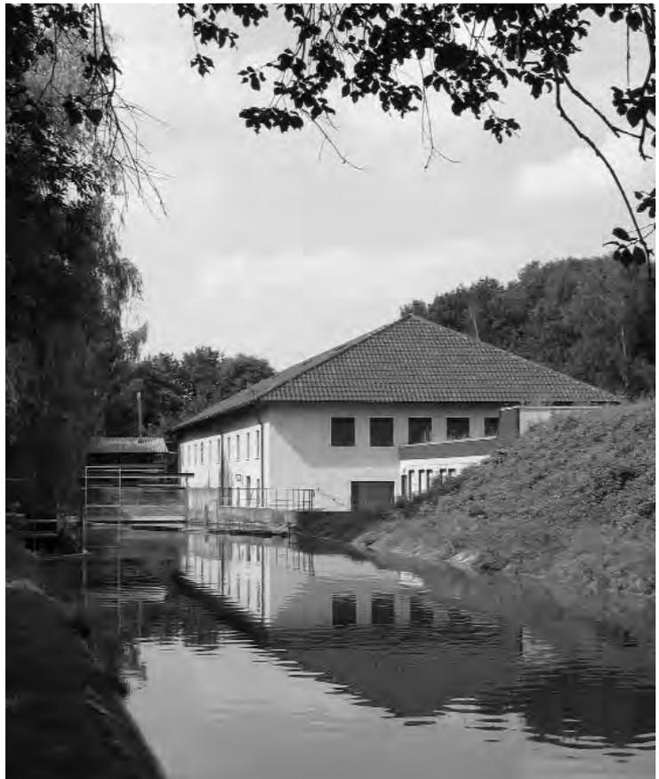
1944 wurde das Werk bei einem Luftangriff zerstört und außer Funktion gesetzt. Nach dem Wiederaufbau 1945 steht heute anstelle der alten Architektur und Technik ein schmukloser, kubischer Putzbau mit Walmdach. In diesem stehen zwei Elektro-Kreiselpumpen modernster Technologie, während die alte Wasserkraft in einem privaten Klein-Elektrowerk genutzt wird.
