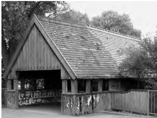
nem für Augsburg einzigartigen technischen Denkmal, einem hölzernen Schütztafel-Ziehwerk mit Sprossentretrad. Dieses ermöglichte im Gegensatz zu einem schnelleren Tretrad mit Innenlaufzylinder die Ausübung eines ziemlich starken Antriebsdrehmomentes. Der Betreiber konnte hier durch die Hebelwirkung des Rades eine höhere Zugkraft bewirken.
