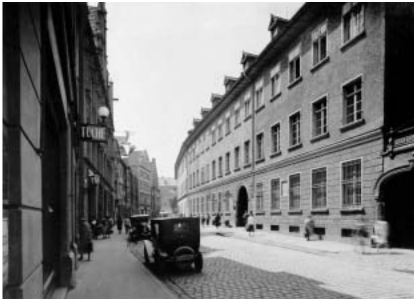
Der Eingang zum Stadtmarkt in der Annastraße. Blick von Norden
