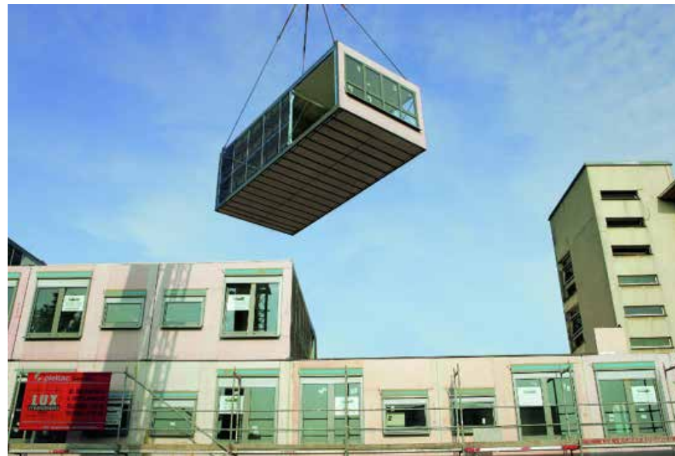
Modul-Bau – Montage von Raumelementen (Foto Alho)
