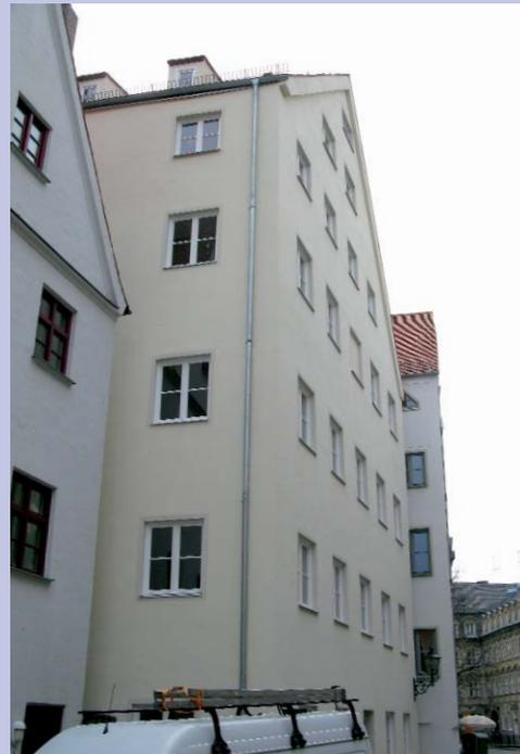
Das Handwerkerhaus am Vorderen Lech mit den Lagerflächen im zweistöckigen Dachgeschoss führte seit dem Krieg ein vernachlässigtes Dasein. Im Rahmen der nun erfolgten Komplettsanierung konnte durch eine Fassadendämmung und Aufdachdämmung auch eine energetische Verbesserung erreicht werden. Durch den Einbau von zum Gebäude passenden Holzfenstern fügt sich dieses Haus nun wieder in die Reihe der stattlichen Altstadtgebäude ein.
