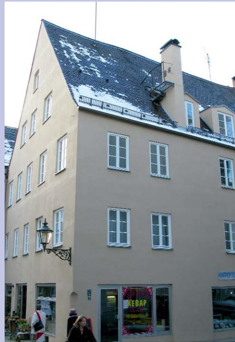
Das in der Altstadt im Lechviertel gelegene dreigeschossige Bürgerhaus stammt im Kern aus dem 16./17. Jh. Bei den Befunduntersuchungen an der Fassade konnten noch Reste einer Hausbemalung aus der Entstehungszeit nachgewiesen und gesichert werden. Das Gebäude erhielt eine Wärmedämmverbundfassade und konnte somit nicht nur optisch sondern auch energetisch wesentlich verbessert werden. Mit seinen neuen denkmalgerechten Holzfenstern stellt das Anwesen wieder einen Eckpunkt in der Weißen Gasse dar.
