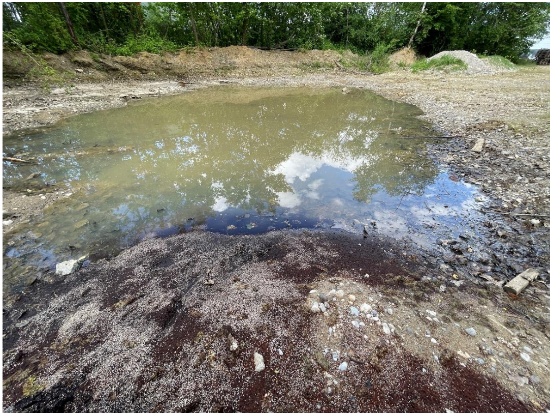
Abbildung 8: Baustellengewässer östlich des Zentralgebäudes
