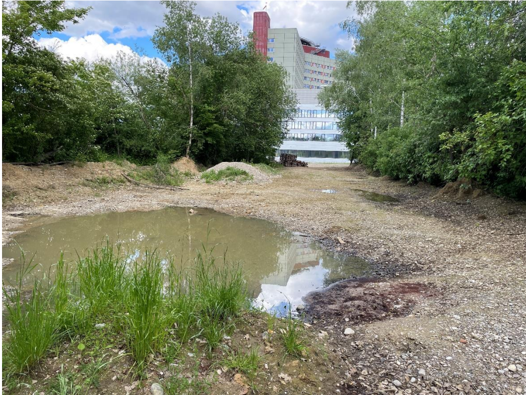
Abb. 9: Gewässer auf der Baustellenfläche westlich des Zentralgebäudes
